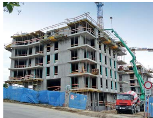
▲ Betonáž stropnej konštrukcie bytového domu A
