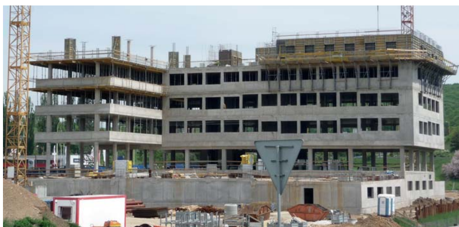
▲ Výstavba prvej zelenej budovy v Košiciach pomocou nasadenia Doka-debniacich systémov
