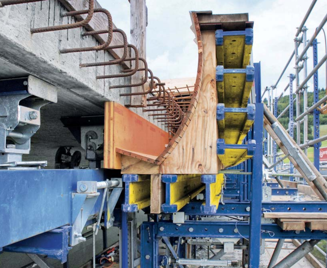
▲ Nosníkové debnenie Top 50 ako základ pre elegantný tvar ríms
