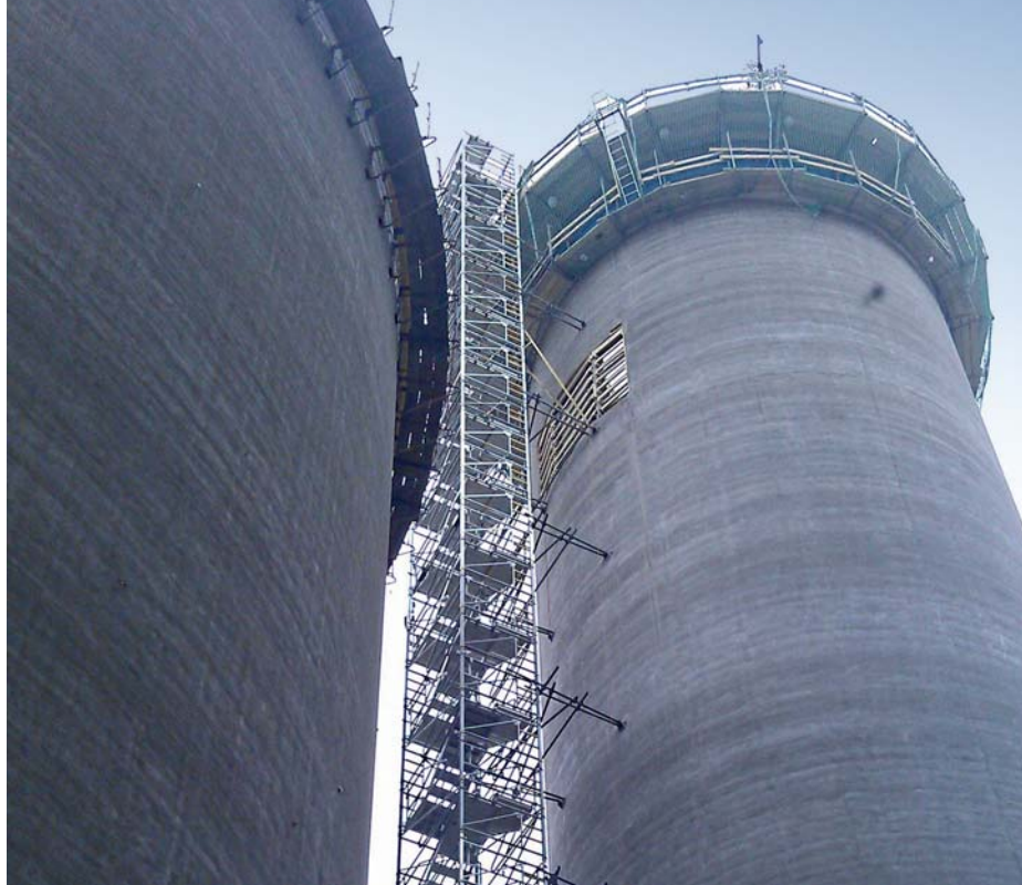
▲ Schodisková veža 250 zabezpečuje bezpečný a obzvlášť stabilný prístup na pracovisko vo výške 54 m
