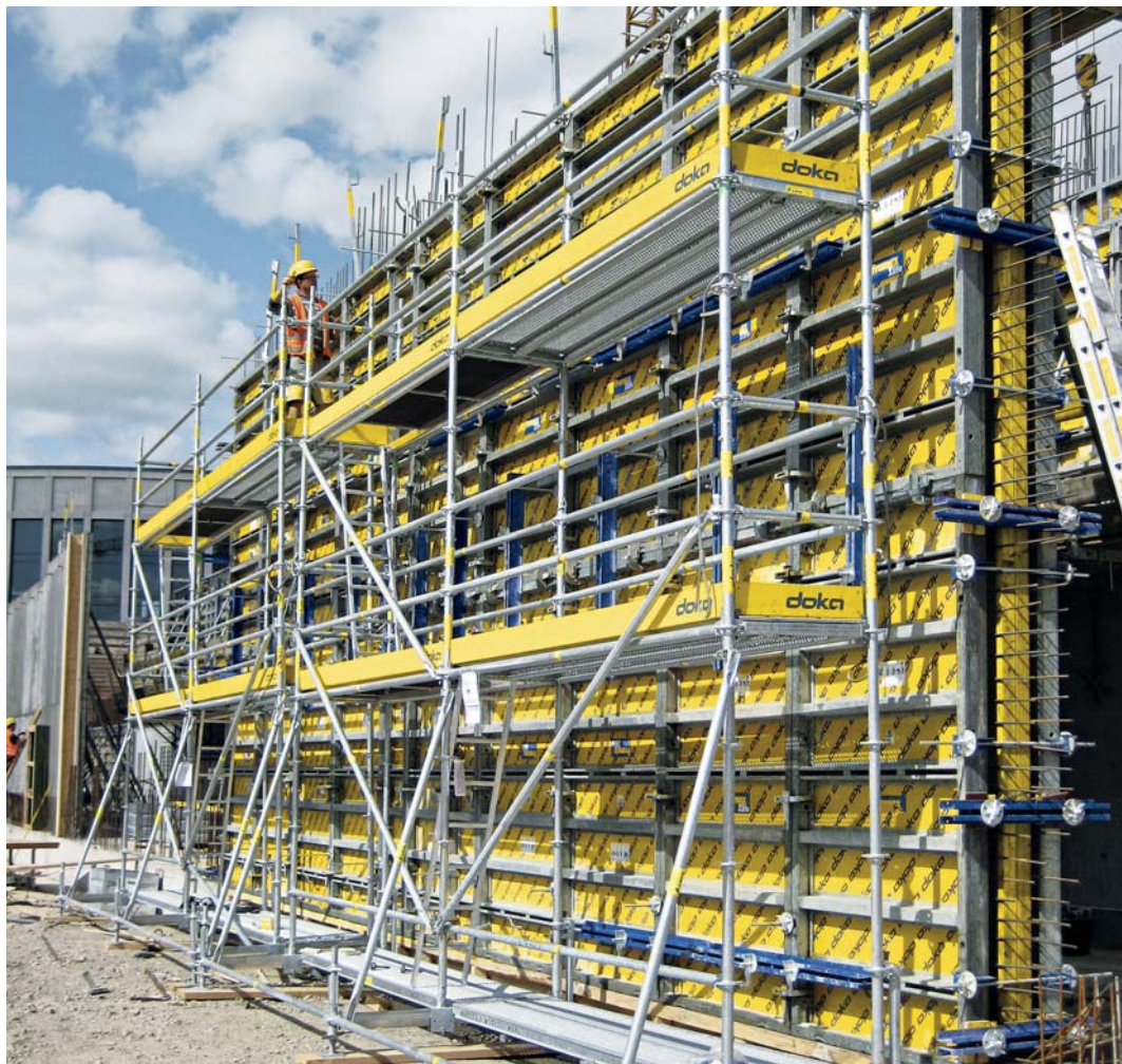
▲ Pracovné lešenie Modul – práce na debnení
