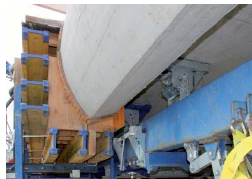
▲ Pomocou jednoducho obsluhovateľného debniaceho vozíka TU vzniká každé dva dni 24 m mostových ríms
