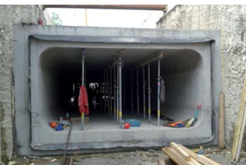
▲ Pohľad na prierez tlakového privádzača zhotoveného pomocou Doka pojzdného debnenia.
