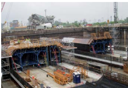
▲ Tunelový vozík vytvorený z flexibilného podporného systému SL-1 je predmontovaný v suchom doku v Baltimore. Začiatkom roka prebiehala skúšobná betonáž jedenástich tunelových segmentov.
