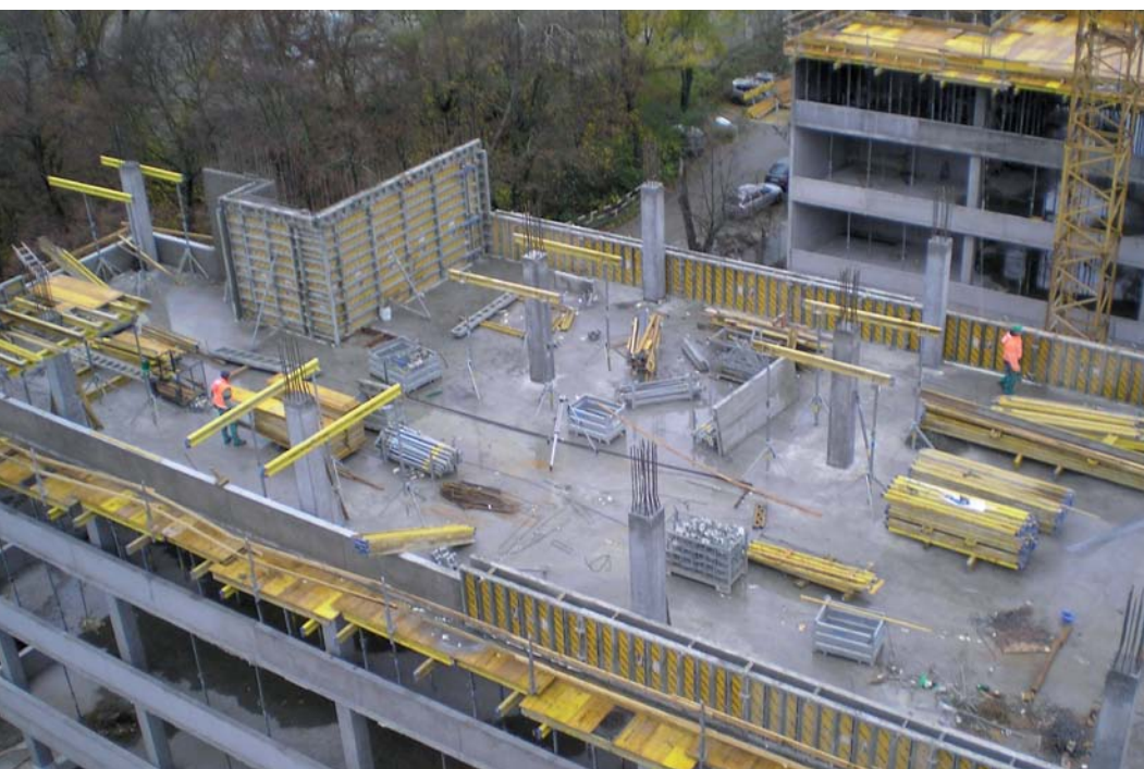
▲ Prebiehajúce debniace práce na parapetoch a stenách v 5. nadzemnom podlaží. Použité stenové debnenie je Framax Xlife.
