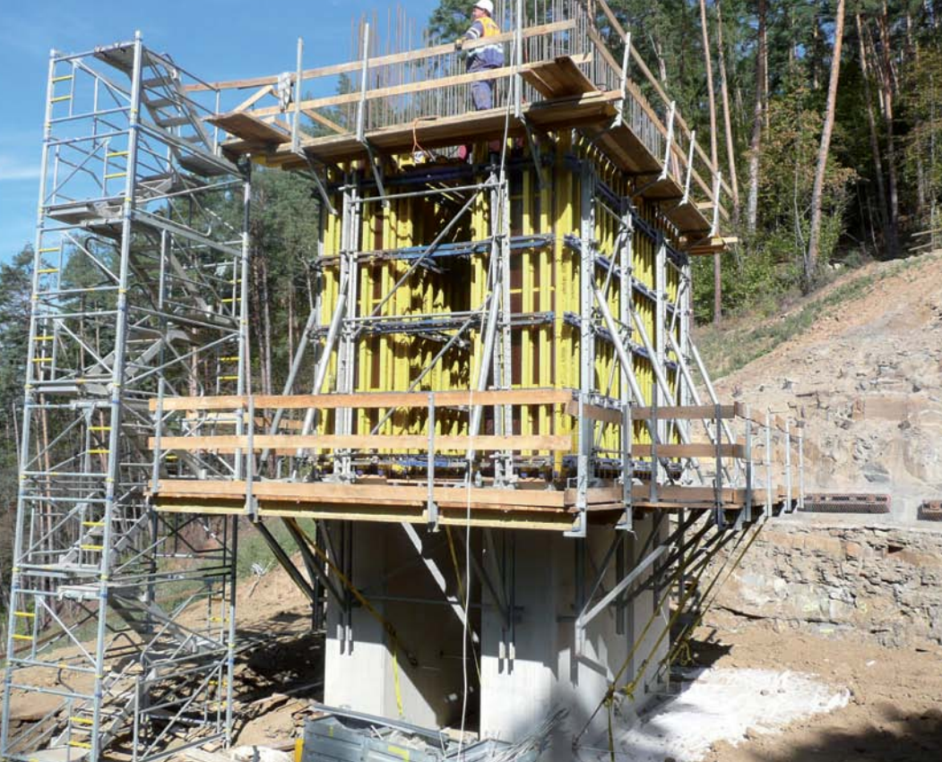
▲ Prvý výškový záber šplhacieho debnenia MF 240 a nosníkového debnenia Top 50 pripravený na betonáž.
