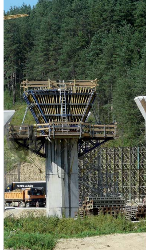
▲ Pohľad na zadebnenú hlavicu piliera. Zložitý tvar hlavice projektovaný v 3D sa zhotovil pomocou nosníkového debnenia Top 50, ktoré bolo predmontované v Doka-servise predmontáže debnenia a dodané včas na stavbu. Plošina, na ktorej je postavené debnenie, je zhotovená z univerzálnych oporných kôz kotvených do drieku piliera.
