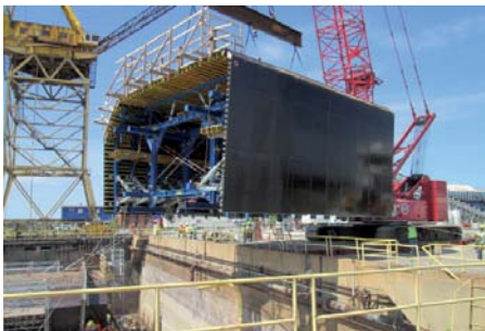
▲ Tunelový vozík vytvorený z flexibilného podporného systému SL-1 je predmontovaný v suchom doku v Baltimore. Začiatkom roka prebiehala skúšobná betonáž jedenástich tunelových segmentov.
