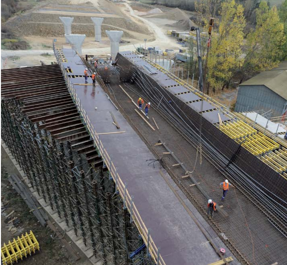
▲ Pohľad na napojenie ťažkého podperného systému Pižmo a podperného systému Staxo 100. Na mostovke aktuálne prebieha debnenie krídel mostovky.
