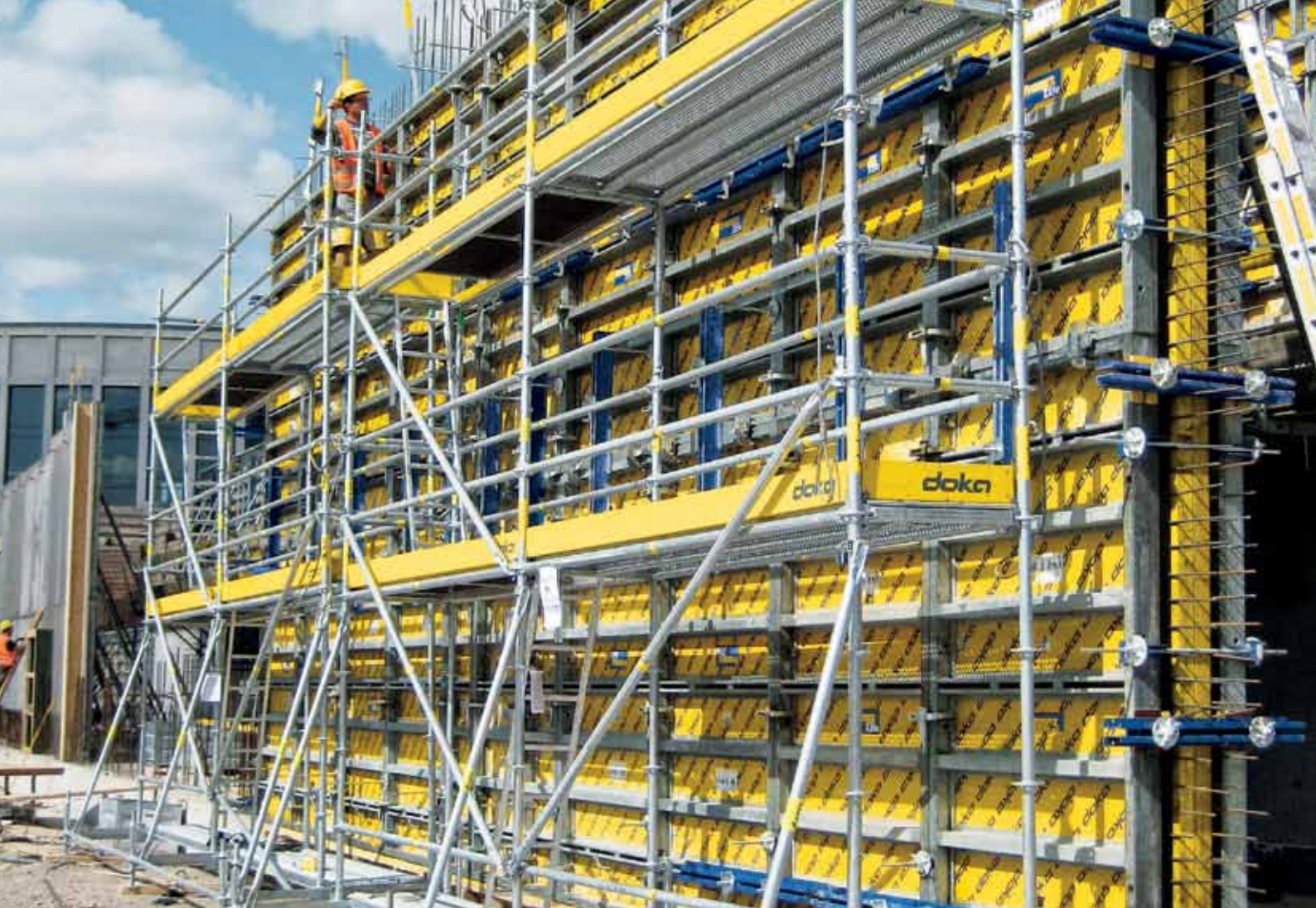
▲ Pracovné lešenie Modul – práce na debnení.
