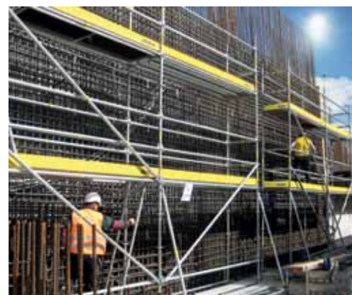
▲ Pracovné lešenie Modul – práce na vystužovaní.
