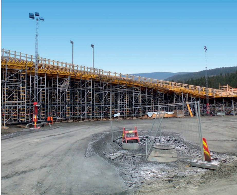
▲ Vysokoučinný podperný systém Staxo 100 podopiera panely vyhotovené z nosníkového debnenia Top 50.
