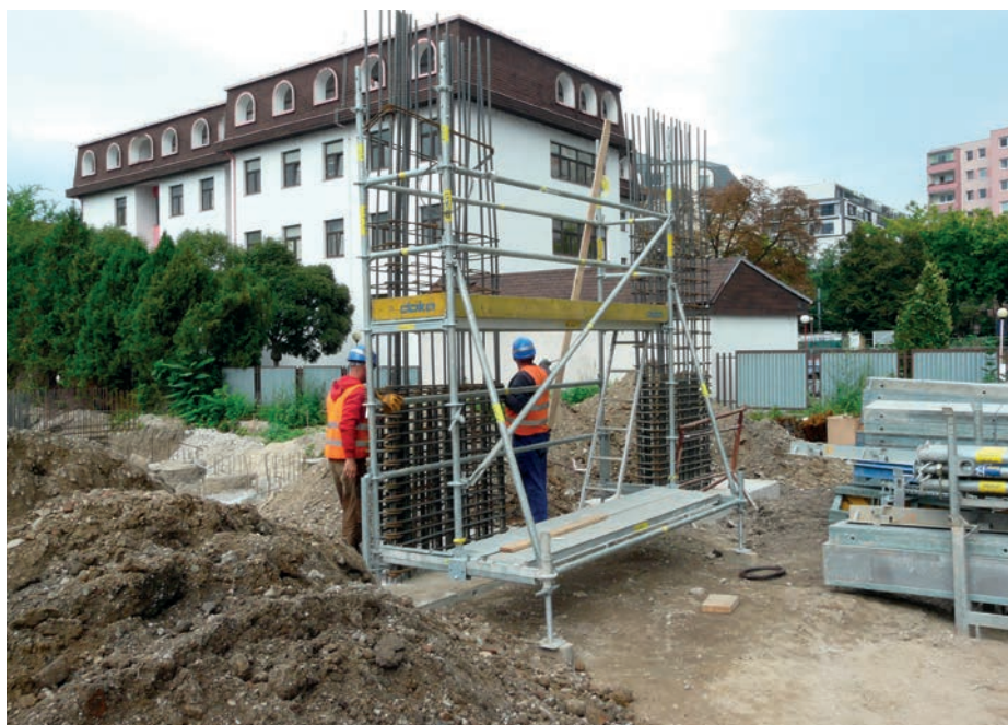
▲ Pracovné lešenie Modul pripravené pre vystužovacie práce.
