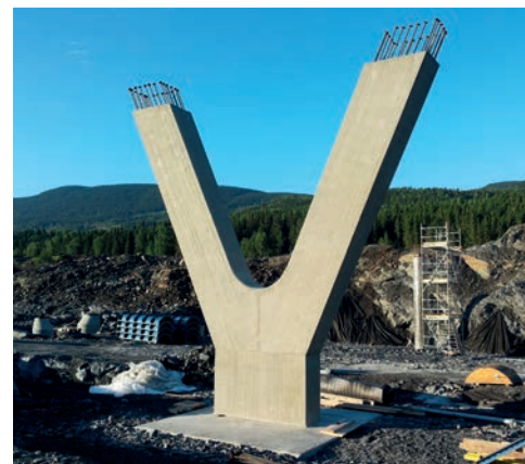
▲ Pilier v tvare Y bol zhotovený v jednom výškovom zábere pomocou nosníkového debnenia Top 50.
