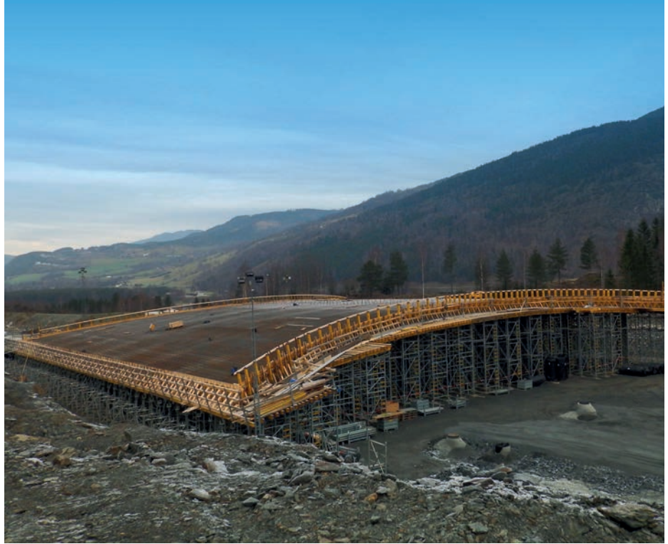
▲ Výstavba mosta na diaľnici E6 Frya – Vinstra v Nórsku napreduje. Hlavným nosným systémom je podperný systém Staxo 100.
