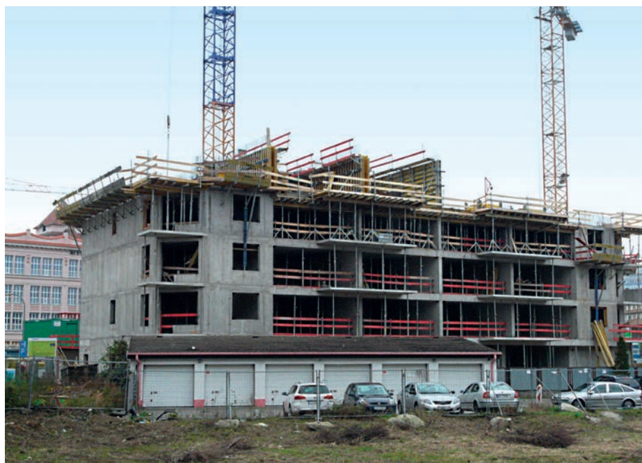
▲ Výstavba 4. NP výškoveho objektu Jégého alej IV. Realizácia jedného podlažia s rozlohou cca 760 m 2 trvá 10 – 11 dní.
