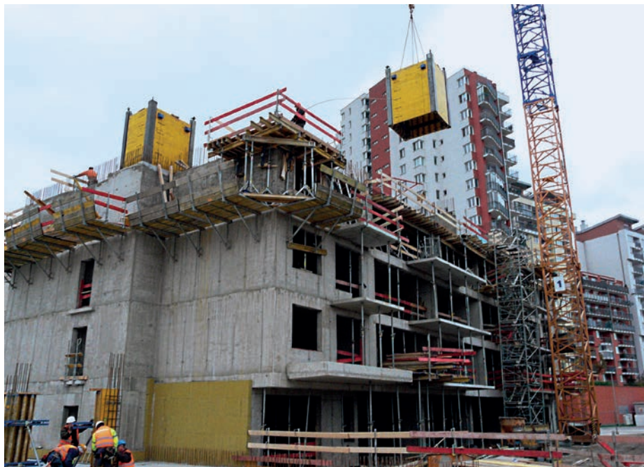
▲ Premiestňovanie zostavy vnútorného šachtového debnenia vytvoreného z nosníkového debnenia Top 50 v kombinácii s oddebnovacími rohmi pomocou žeriava.
