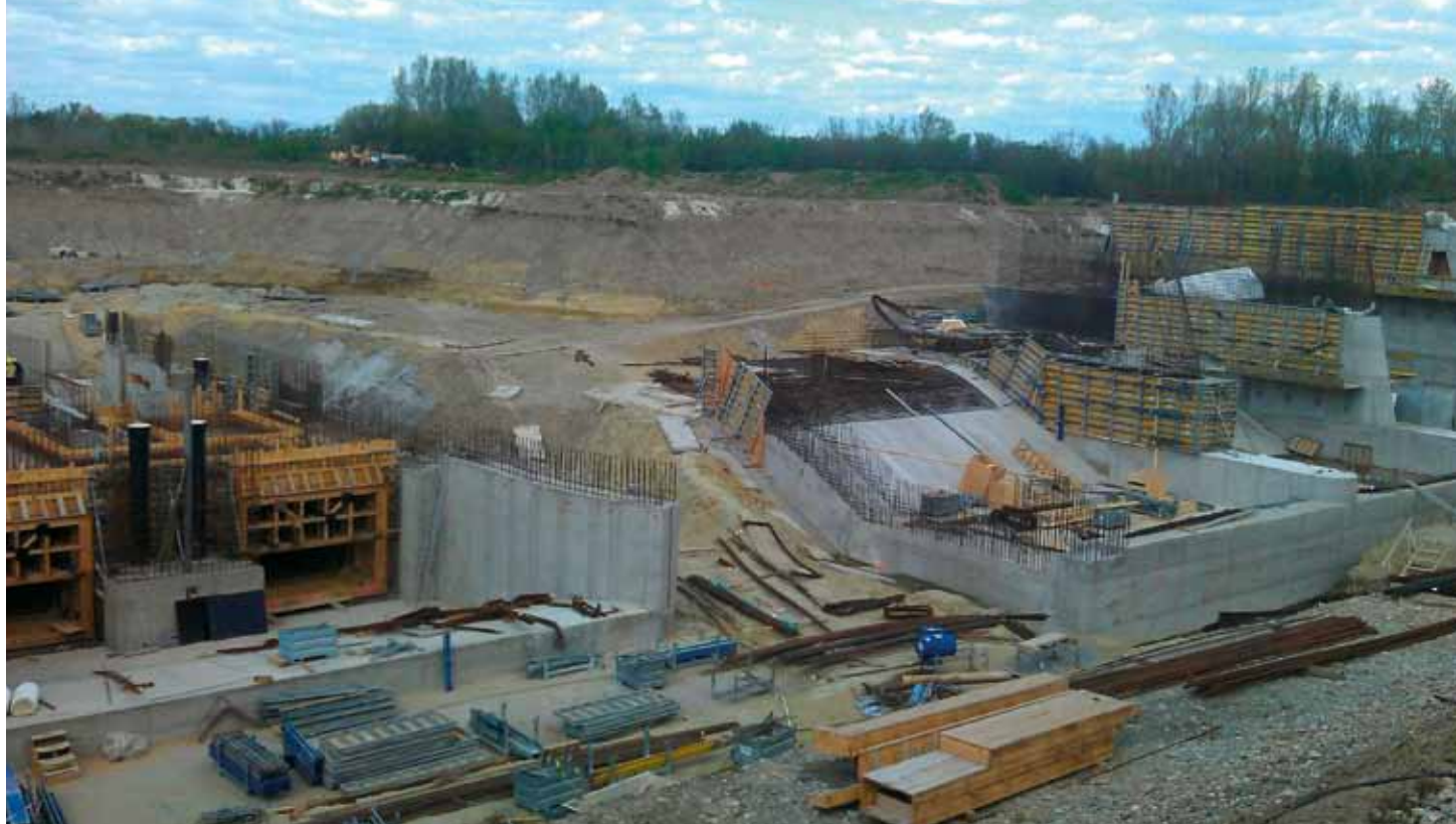
▲ Celkový pohľad na rozostavanú malú vodnú elektrárňu.
