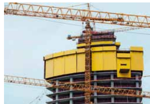
▲ So systémom zdvíhania stolov TLS sa dá stropné debnenie premiestniť bez použitia žeriava a zároveň je integrovaný do ochranného štítu Xclimb 60.
