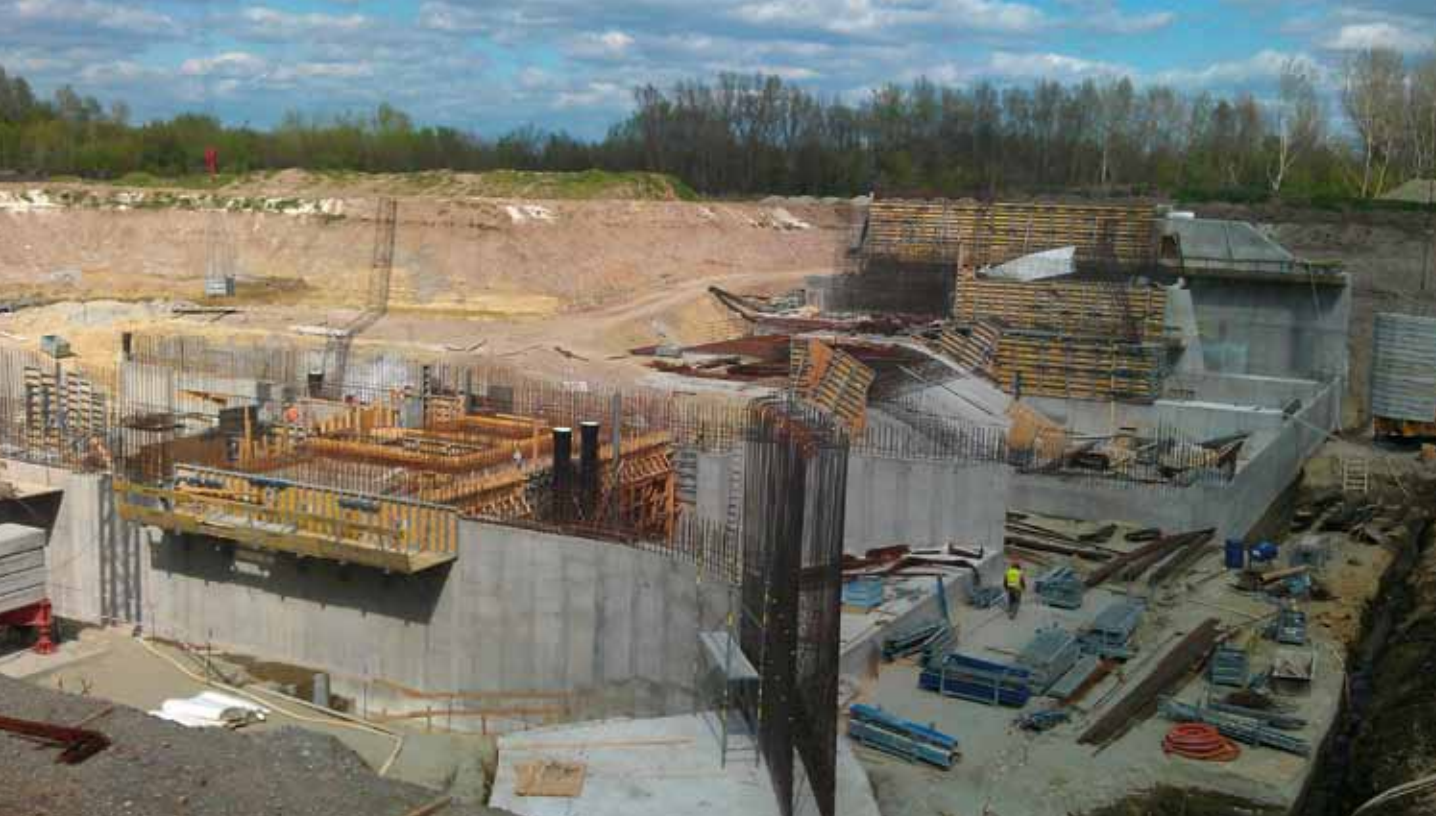
▲ Pomocou Doka-debnenia sa realizuje budova MVE (vľavo) a objekt Hať (vpravo).
