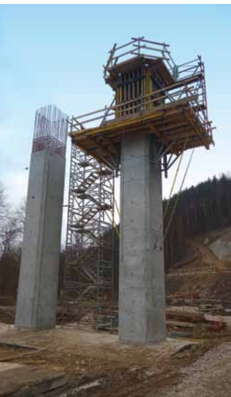
▲ Realizácia vyšších pilierov prebieha pomocou šplhacieho debnia MF 240, ktoré vytvára únosnú plošinu pre nosníkové debnenie Top 50 s výškou 3,6 m.
