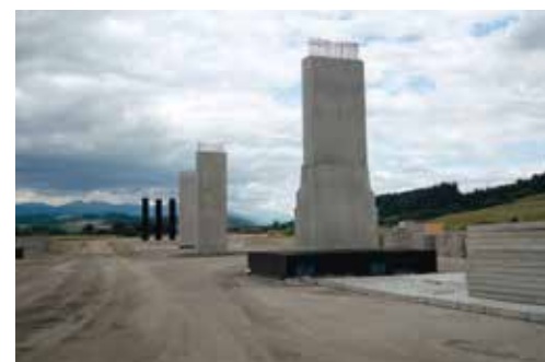
▲ Všetky piliere mosta sa zhotovili jednoducho a rýchlo pomocou výkonného rámového debnenia Framax Xlife s výškou 9,9 m. Piliér č. 3 (na obrázku prvý sprava) sa od ostatných piliérov odlišoval vytvarovaným podstavcom.
