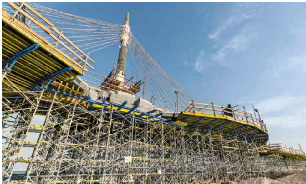
▲ Pri každom betonárskom zábere bolo potrebné podperný systém výškovo prispôsobiť, čo sa s flexibilným podperným systémom Staxo 40 zvládlo rýchlo a efektívne. © Doka
