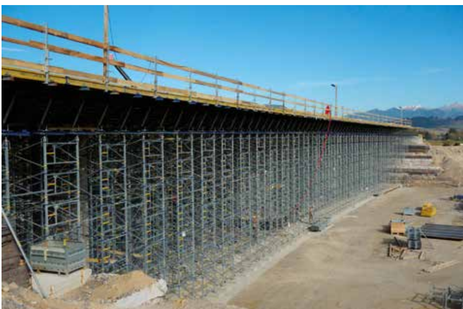
▲ Nosníkové debnenie Top 50 určujúce konečný tvar mostovky je uložené na podpernom systéme Staxo 100. Na mostovke momentálne prebiehajú vystužovacie práce.
