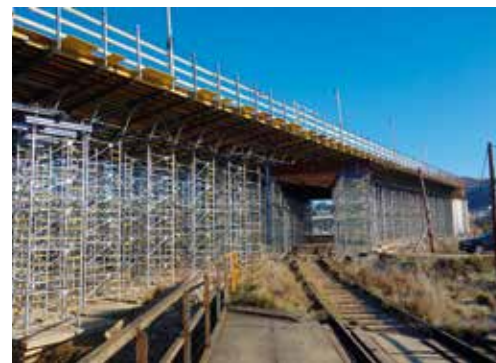
▲ Zhotovenie prejazdu so šírkou 4,2 m pomocou kombinácie podperného systému Staxo 100 a ocelových profilov IPN 500.
