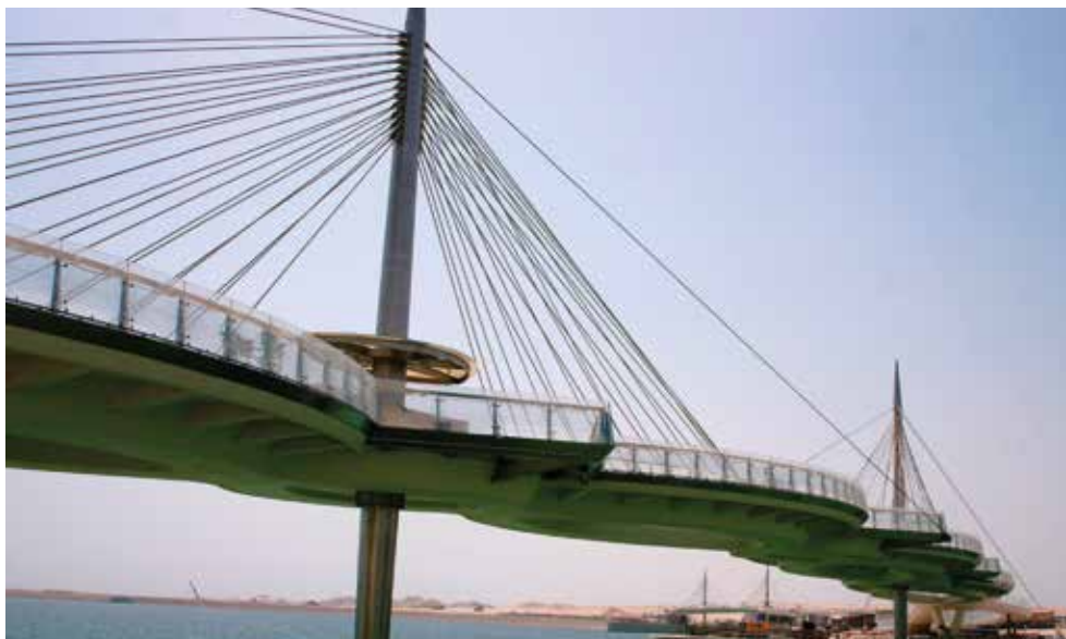
▲ Výsledný elipsový dizajn mosta je architektonickým pútačom novovznikajúceho mesta. © Doka
