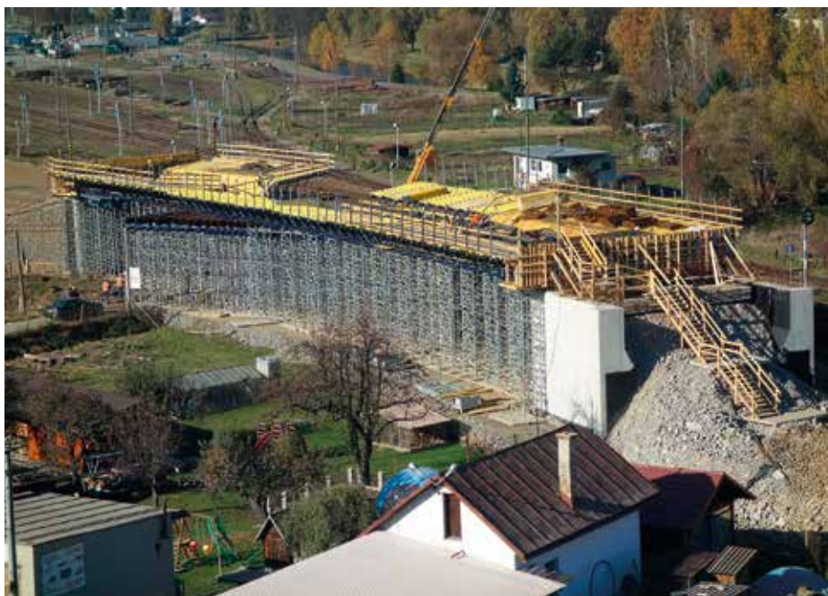
▲ Doskový most SO 202 s dĺžkou 80 m sa realizoval pomocou výkonného podperného systému Staxo 100 a nosníkového debnenia Top 50.
