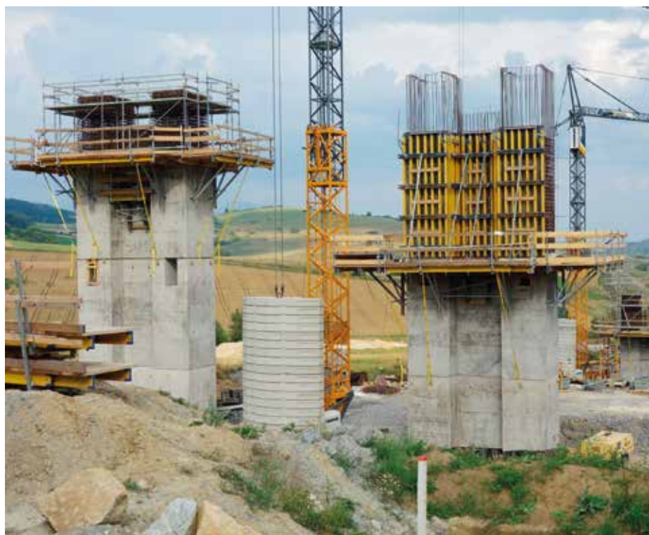
▲ Rôzne štádiá realizácie piliarov pomocou nasadenia šplhacieho debnenia MF240 a nosníkového debnenia Top 50.
