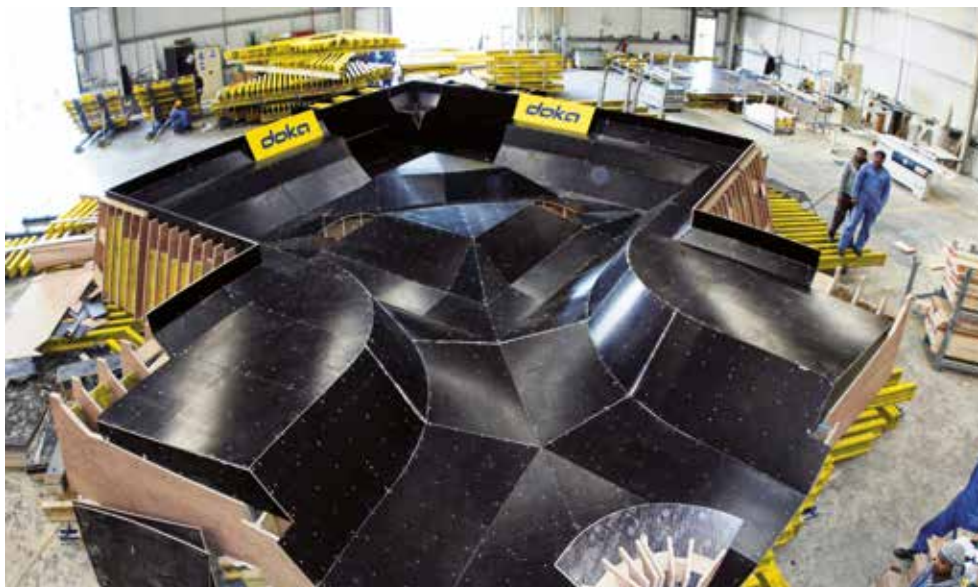
▲ Debnenie na zhotovenie betónovej dosky mostnej konštrukcie sa predmontovalo v servise predmontáže debnenia. Vďaka použitiu debniacej dosky Dokaplex sa dosiahla kvalita pohľadového betónu. © Doka
