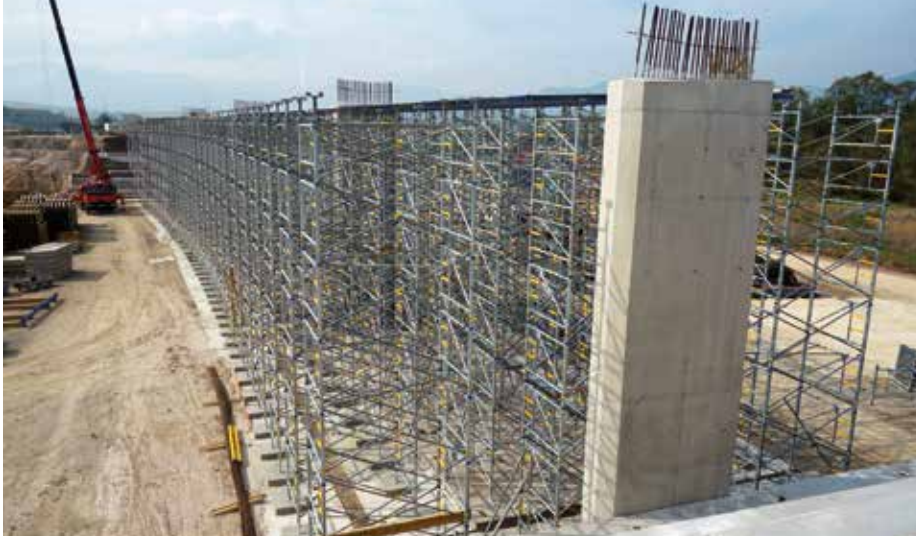
▲ Realizácia mostovky na pevnej skruži vytvorenej zo 112 veží podperného systému Staxo 100. Priemerná výška podopretia je 9 m.
