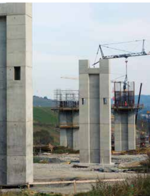
▲ Piliere v tvare „kostičky“ s variabilnou výškou od 15,7 m do 36,6 m s otvormi určenými na nasadenie výsuvnej skruže.
