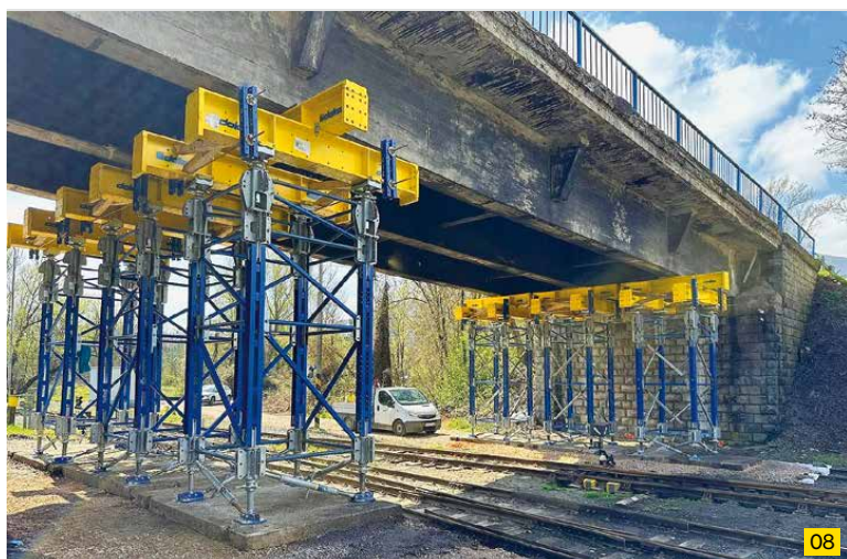
08 Prvé nasadenie podperného systému Doka UniKit na Slovensku ako dočasné podopretie mosta v havarijnom stave.
