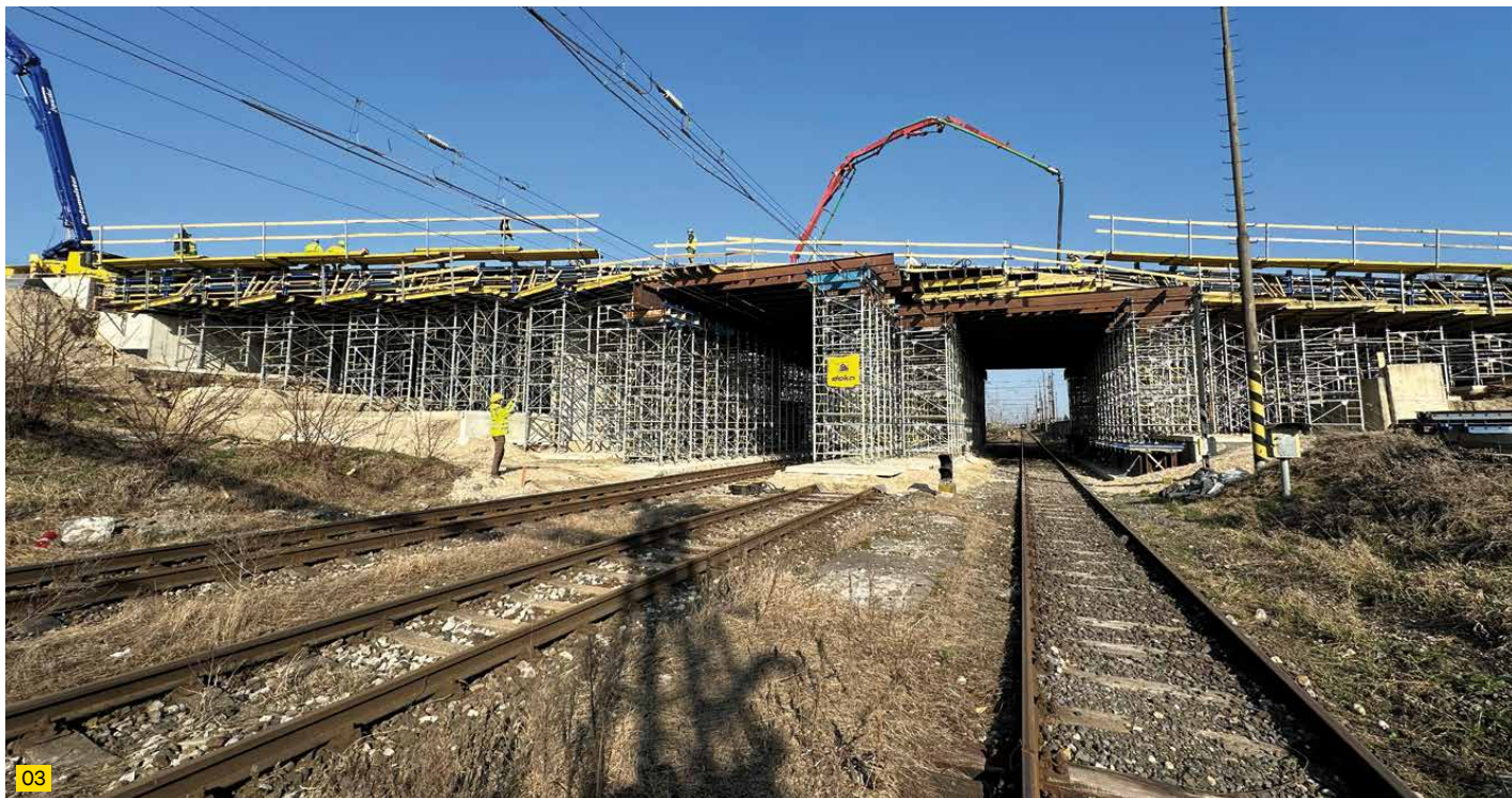
03 Pohľad na betonáž mostovky obj. 62-013. Podopretie nosnej konštrukcie pomocou podperného systému Staxo 100 a nosníkového debnenia Top 50.
