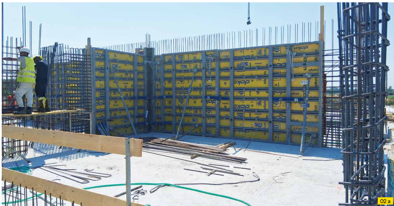
02 a 02 b Rámové debnenie Framax Xlife plus 3,0 m pri výstavbe zvislých konštrukcií.
