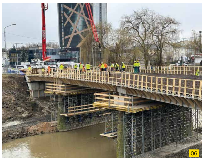
06 Rekonštrukcia Stráňanského mosta v Michalovciach sa realizovala pomocou podperného systému Staxo 100 a špeciálnych plošín.
