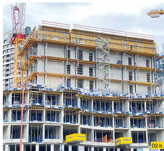
02 a 02 b Pohľad na prebiehajúcu výstavbu SKY PARK Tower. Komunikačné jadro sa realizuje pomocou hydraulického samošplhacieho systému Xclimb 60 a nosníkového debnenia Top 50. Výstavba jadra budovy je popredu od ostatných konštrukcií o 3 podlažia. Tak vzniká samostatné pracovisko, ktoré je nezávislé od výstavby ostatných zvislých a vodorovných konštrukcií.
