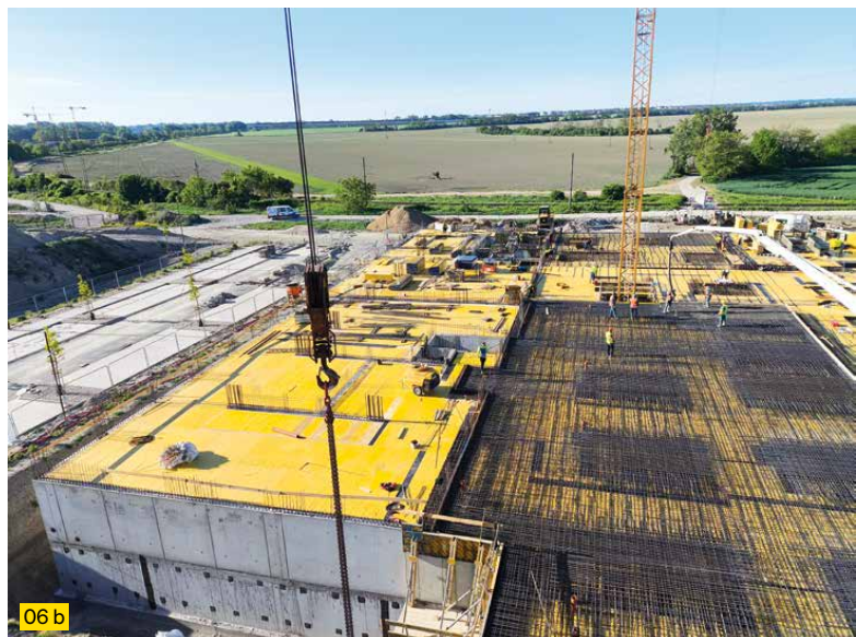
04 Detail na integrovanú maticu v ráme panelu Framax Xlife plus, 05 Detail na kotvu Framax Xlife plus v nasadení, 06 a 06 b Vodorovné konštrukcie sa realizujú pomocou nosníkového debnenia Dokaflex s použitím debniacej dosky 3SO 21 mm
