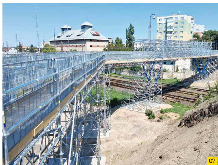
07 Dočasná lávka pre peších v Sereďi, vybudovaná ako náhradné prepojenie ponad železničnú trať z lešenia Doka Ringlock.
