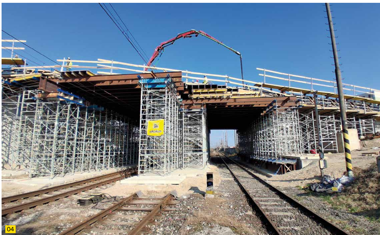
03 Pohľad na betonáž mostovky obj. 62-013. Podopretie nosnej konštrukcie pomocou podperného systému Staxo 100 a nosníkového debnenia Top 50.
