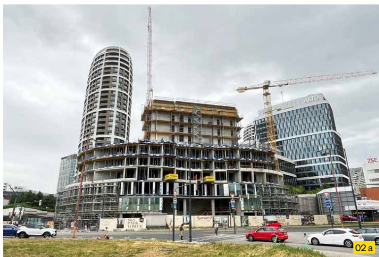
02 a 02 b Pohľad na prebiehajúcu výstavbu SKY PARK Tower. Komunikačné jadro sa realizuje pomocou hydraulického samošplhacieho systému Xclimb 60 a nosníkového debnenia Top 50. Výstavba jadra budovy je popredu od ostatných konštrukcií o 3 podlažia. Tak vzniká samostatné pracovisko, ktoré je nezávislé od výstavby ostatných zvislých a vodorovných konštrukcií.
