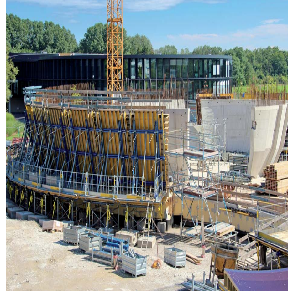
▲ Сначала монолитные стены расширяются вверх, а через несколько заливок снова сужаются, наклоняясь друг к другу. Требования к опалубке для таких изогнутых стен очень велики.
