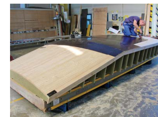
▲ Сборка всех оригинальных элементов опалубки производится специалистами Doka в Отделе предварительного монтажа.
