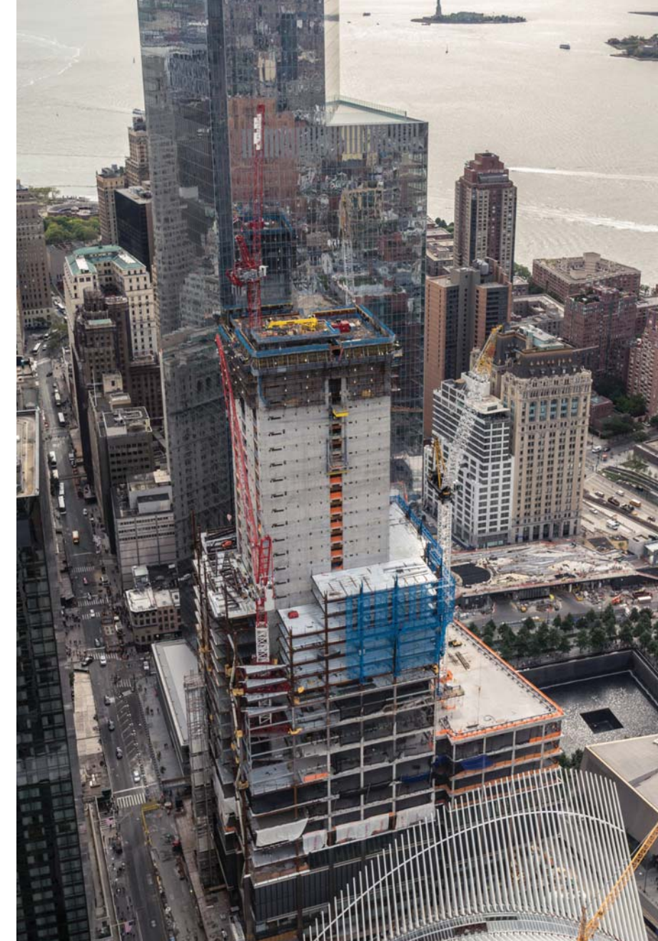
▲ Самоподъемная опалубка Doka SKE100 plus работает на наружных стенах и перемещает большие рабочие подмости с рамной опалубкой Frami S и балочной опалубкой Top 50 S. Ядро здания возводится при помощи Doka Super Climber Plattform со скоростью 3,9 м в неделю.
