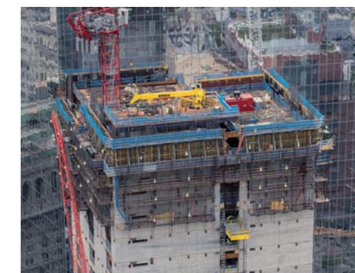
▲ Закрепленные на наружных стенах подъемники столов перекрытий TLS обеспечивают независимое от крана перемещение опалубки, оборудования и материалов.
