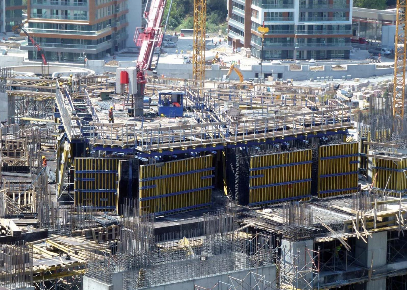
▲ Треугольная форма здания ставит особую задачу с точки зрения опалубки; самоподъемная платформа SCP служит надежным решением, обеспечивающим высокий темп ведения работ.
