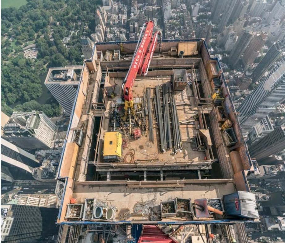
▲ Поддача бетона на перекрытие, в стены и колонны ведется независимо от крана.
