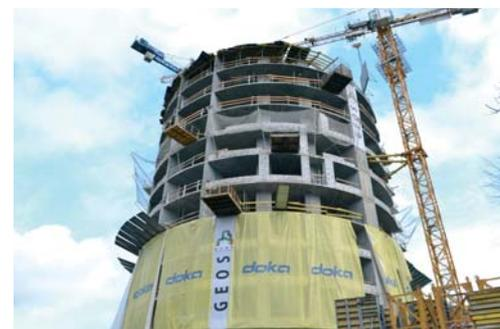
▲ Сложная геометрия здания и насыщенность монолитного каркаса стали одной из строительных задач, успешно решить которую помогли опалубочные системы Doka.
