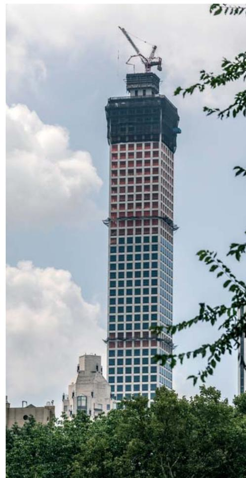
▲ Эффективные системы опалубки Дока обеспечили 3,5-дневный цикл бетонирования.
