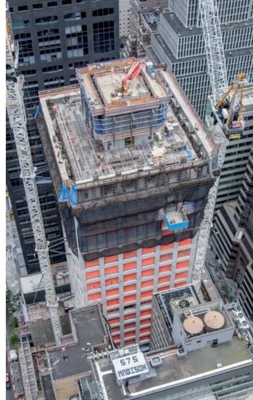
▲ Автоматическая самоподъемная система Xclimb 60 перемещает специальную стальную опалубку.
