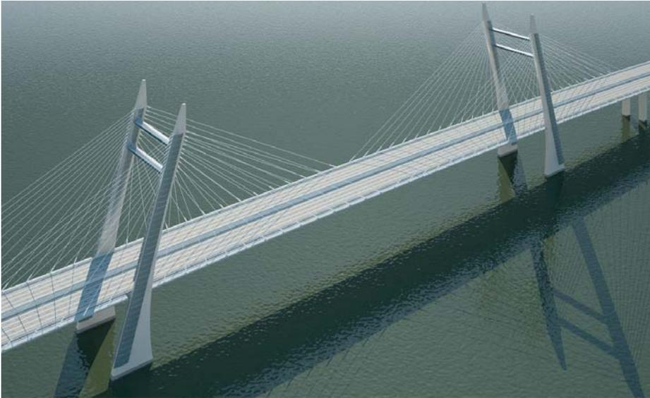
◀ Вантовый мост через Корабельный фарватер протяженностью 620 м с расстоянием между пилонами 320 м. ©www.ica-whsd.com
