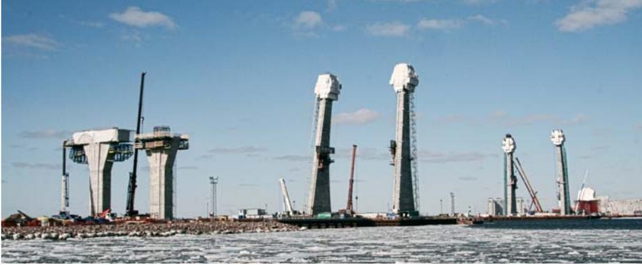
◀ Решение Doka для пилонов сочетает автоматическую самоподъемную и подъемно-переставную опалубку. Закрытое ограждение на всех уровнях обеспечивает защиту от ветра и неблагоприятных погодных условий.
