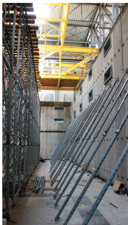
▲ Az előregyártott pakettfalak ankerezése, megtámasztása.
