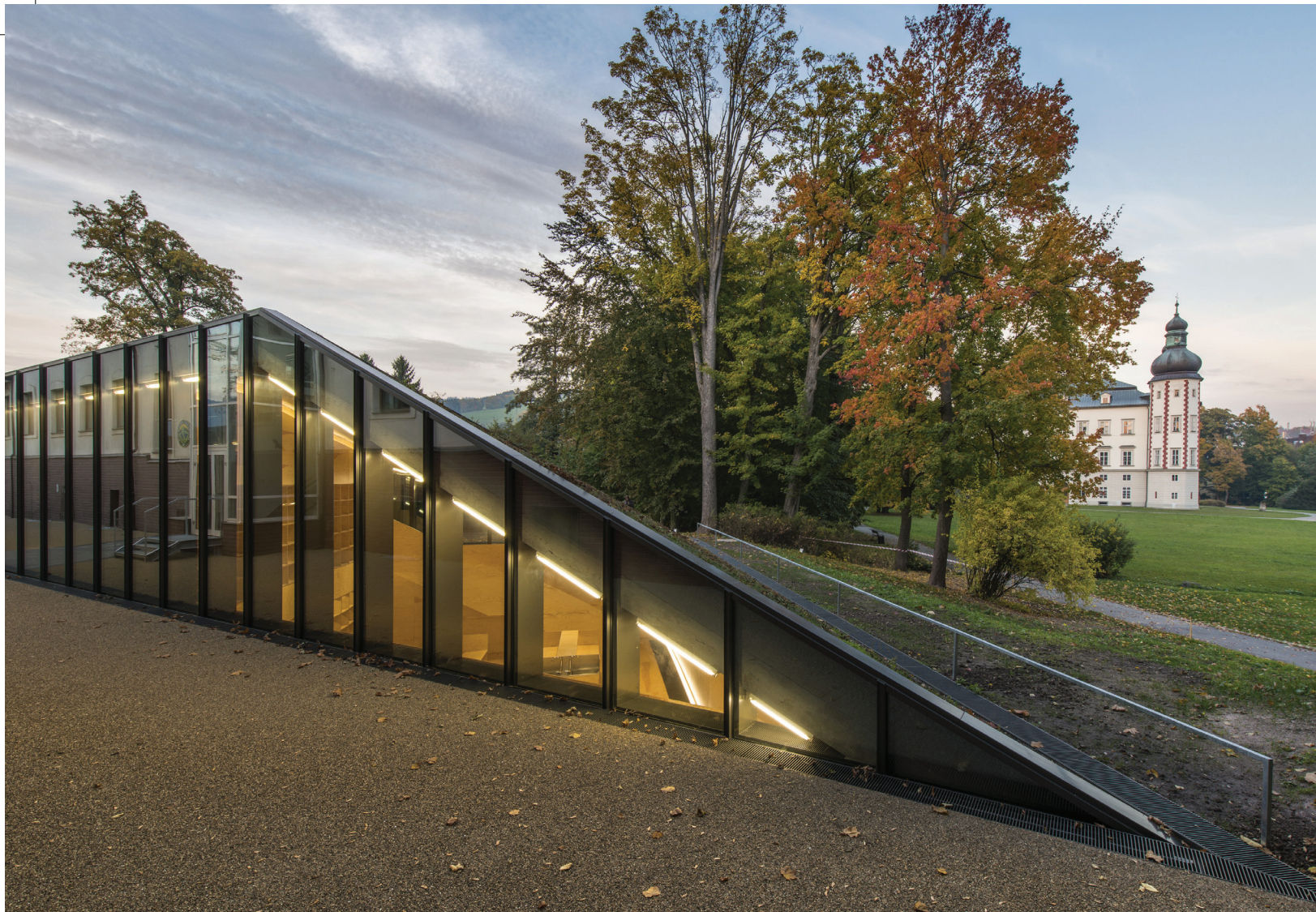
▲ A különleges épület tetőszerkezete.
