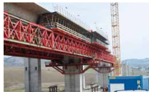
▲ Pri zhotovovaní komôrkového prierezu nosnej konštrukcie mosta bolo nasadené nosníkové debnenie Top 50.
