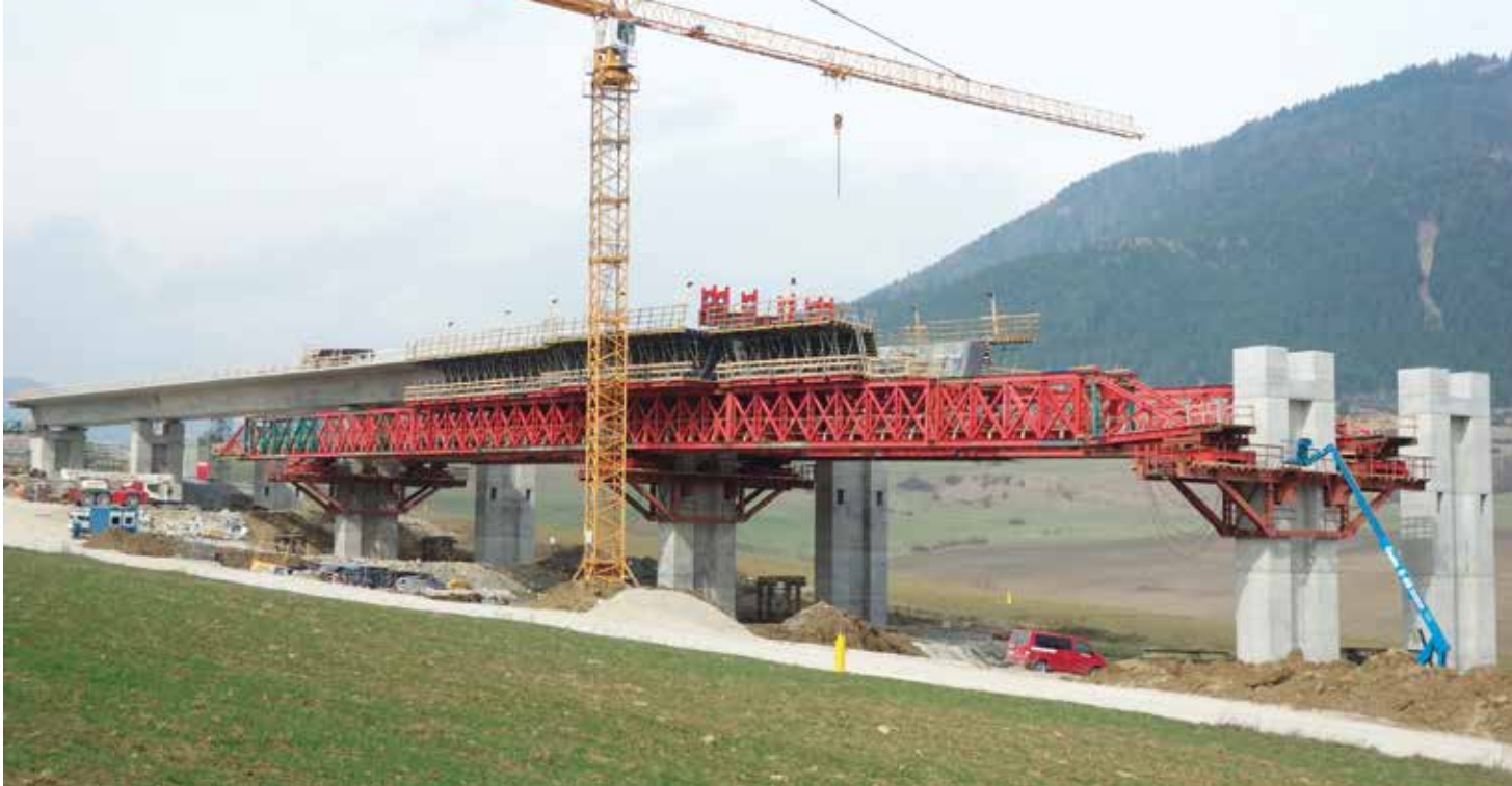
▲ Výstavba nosnej konštrukcie mosta pomocou postupnej betonáže po jednotlivých poliach na výsuvnej skruži.
