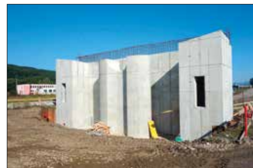
▲ Krajná opora s pilierom je realizovaná pomocou rámového debnenia Framax Xliffe a nosníkového debnenia Top 50.
