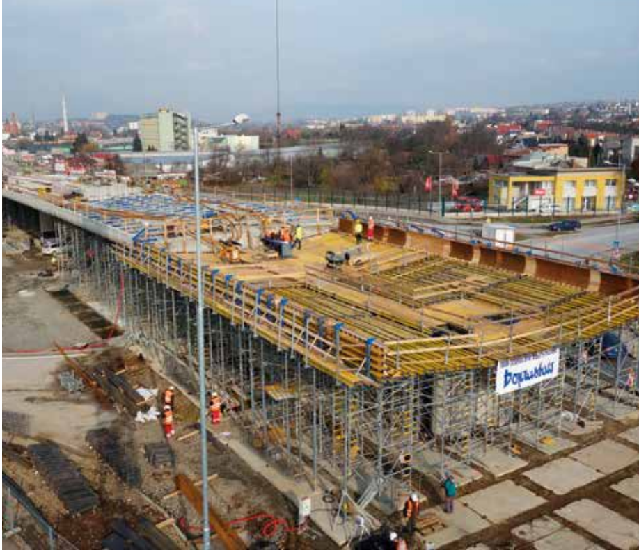
▲ Pohľad na zložito tvarovanú hornú konštrukciu mostovky zadebnenú pomocou podperného systému Staxo 100 a nosníkového debnenia Top 50.
