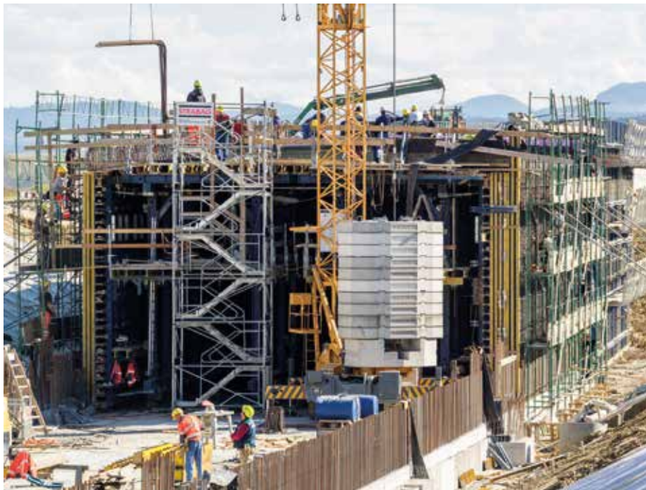
▲ Na efektívne ručné presúvanie vonkajšieho debnenia vyvinula Doka v spolupráci s firmou realizujúcou projekt nové inteligentné riešenie.
