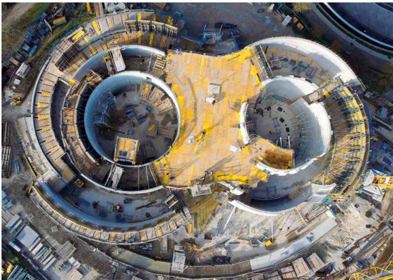
▲ Z architektonického pohľadu pripomína celá stavba ležatú osmičku.
