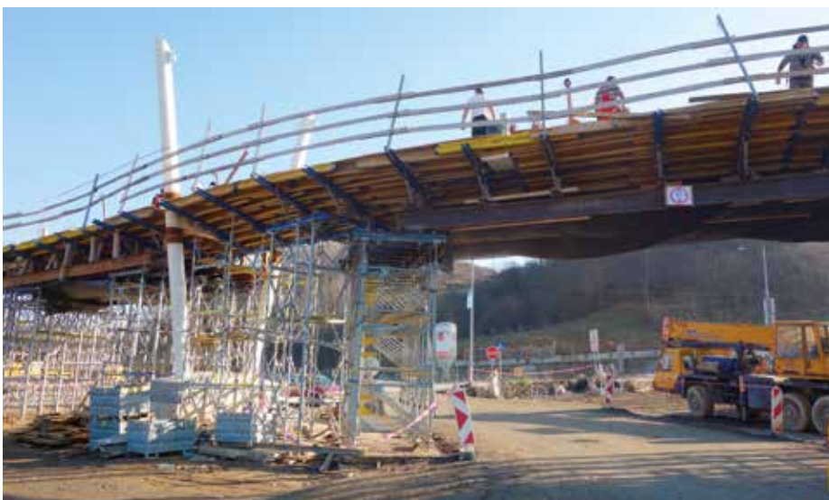
▲ Zhotovenie prejazdu so šírkou 7,2 m pomocou kombinácie podperného systému Staxo 100 a oceľových profilov IPN 450.
