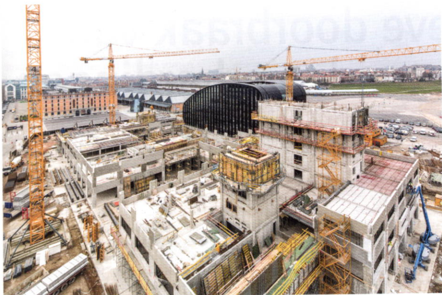
Bij de bouw van het Herman Teirlinckgebouw in Brussel zorgden MF-klimconsoles voor de vereiste veiligheid, eenvoud en flexibiliteit.
