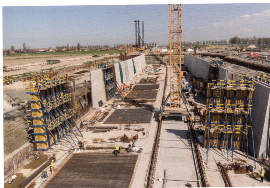
Bij de bouw van de A11-snelweg zijn verschillende types Doka-bekisting gebruikt.
