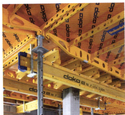
Dokadek 30, een dragerloos, handmatig systeem dat een snelle en veilige opbouw en demontage garandeert.
