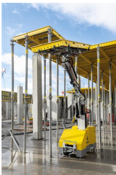
DokaXbot under montage af dækforskallingen Doka Xdek.
