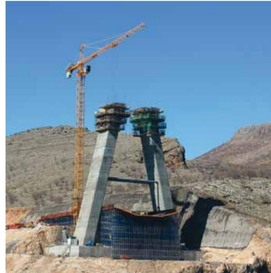
Über dem Euphrat in Südanatolien entsteht die Nissibi-Brücke. Die 610 m lange Schrägseilbrücke wird von 85 m hohen Pylonen gestützt.
