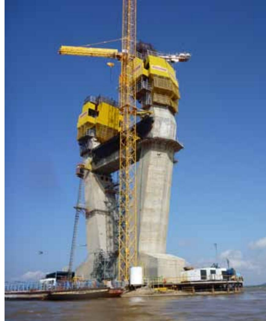
Am Ufer des Orinoco in Venezuela werden zwei Pylone mit einer Schalungs-lösung von Doka in Form gebracht.
