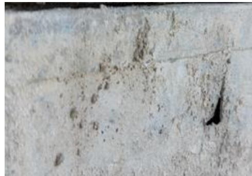
Gat in profiel - las nodig
