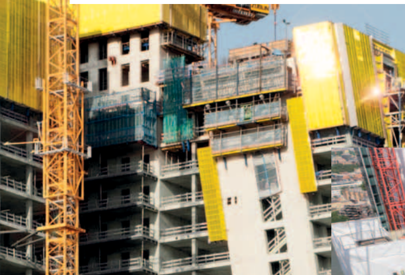
Powłoka poliwęglanowa przepuszczająca światło, wiatroszczelna i nietransparentna
