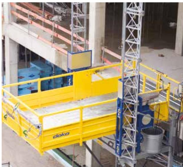
Durch das Umsetzen der Deckentische mit dem Tischhubsystem TLS werden die Kräne entlastet. Dadurch können diese unter Umständen frühzeitig abgebaut und es kann mit dem Herstellen der Außenanlagen begonnen werden.
