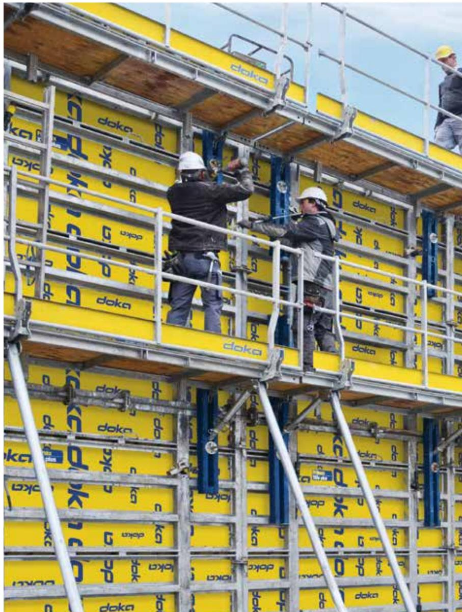
**Einsetzbar bei:** Rahmenschalung Framax Xlife plus, Rahmenschalung Framax Xlife, Rahmenschalung Alu-Framax Xlife, Trägerschalung Top 50, Trägerschalung FF20, Trägerschalung Top 100 tec
