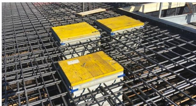
Durchgängige Arbeitssicherheit in jeder Bauphase durch vormontierte Abdeckung der Deckendurchbrüche
