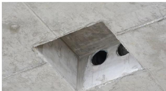
Die Aussparungen können inkl. der Bohrungen für Rohranschlüsse oder andere Einbindungen geliefert werden.
