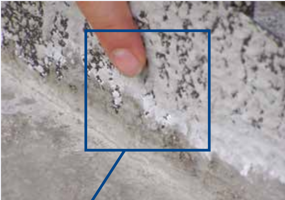
CEMflex VB: Die Kristallisation ist bereits sichtbar.
