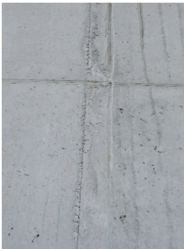
Munkahézag tömítőszalag nélkül
