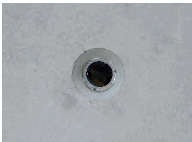
Tömített ankerhely kivérzések és kitörések nélkül
