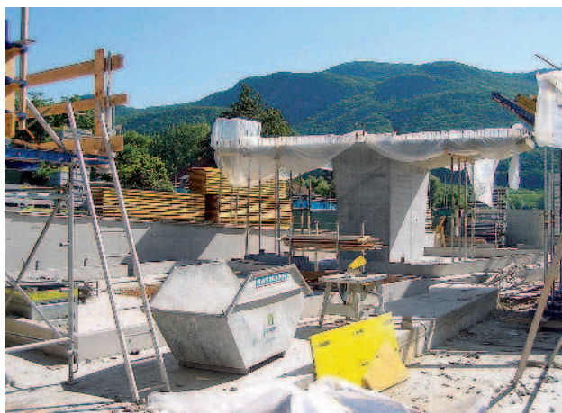
A csatlakozó vasszerelés védelme
