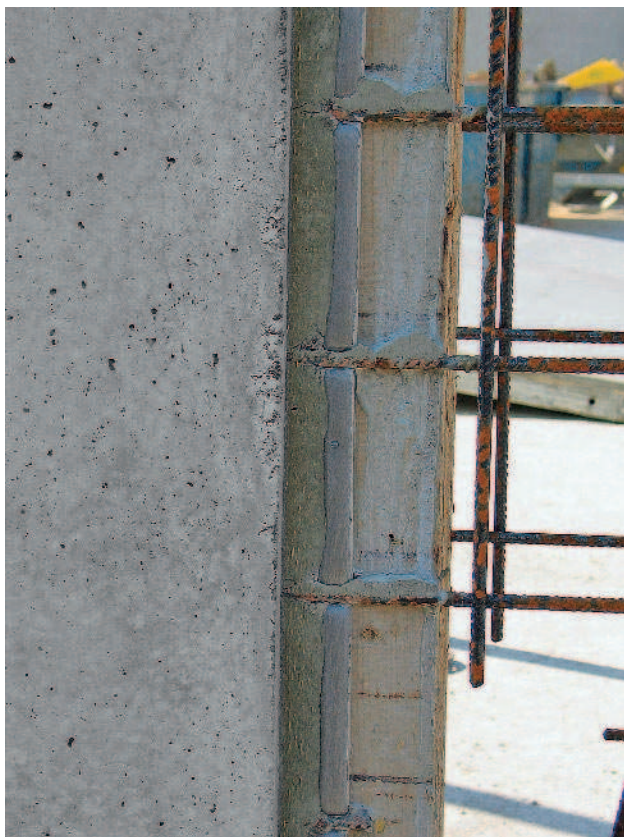
Véglezárás zsaluzata tömítőszinórral
