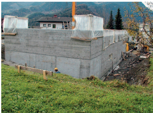
A csatlakozó vasszerelés védelme
