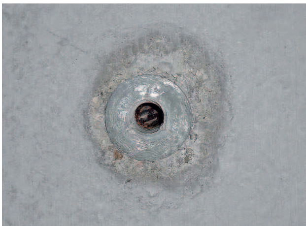
"Kivérzés" a nem tömített ankerhely esetében
