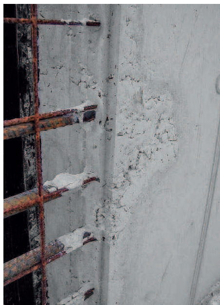
Példa: Tömítetlen véglezárás zsaluzata
