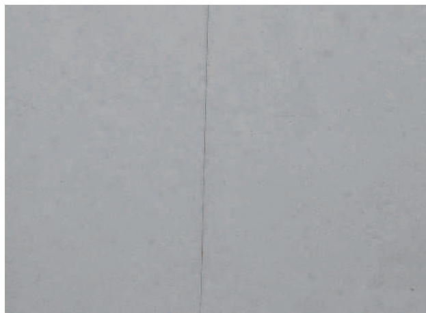
Dokaplex tömített zsaluhéjillesztés betonképe
