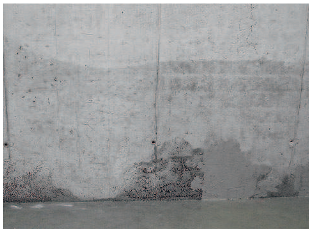
Eredmény tömítőzsinór nélkül
