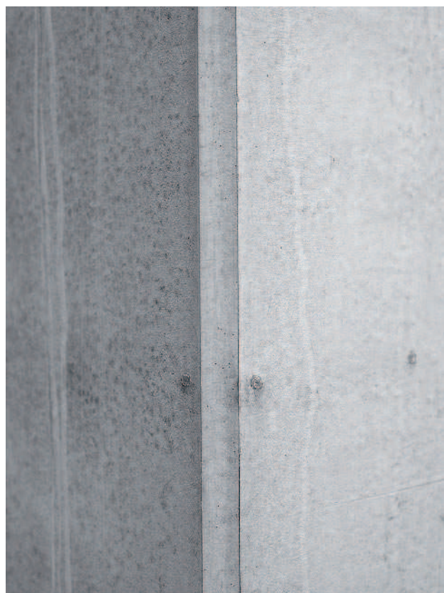
Sarok kialakítása élképzővel
