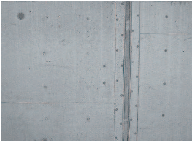
Zsaluhéj csavarkötése az elemek szélén
