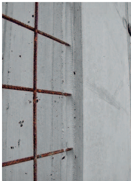
Példa: Tömített véglezárás zsaluzata
