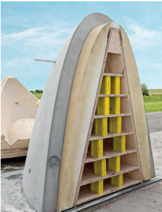
**Ausschalen leicht gemacht:** Zuerst wird die Tragkonstruktion entfernt. Dann können die aufeinander abgestimmten Innenschalungselemente einfach vom Baukörper gelöst werden.
