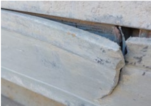
Lengteprofiel gebroken
