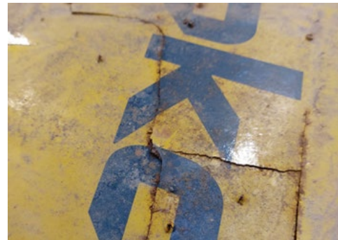
Scheur in bekistingsplaat > 10 cm lengte
