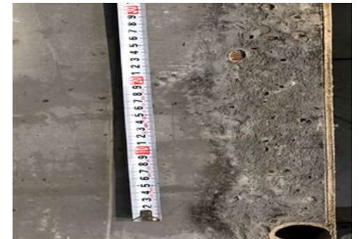
Verbrand bekistingsoppervlak = 10 cm
