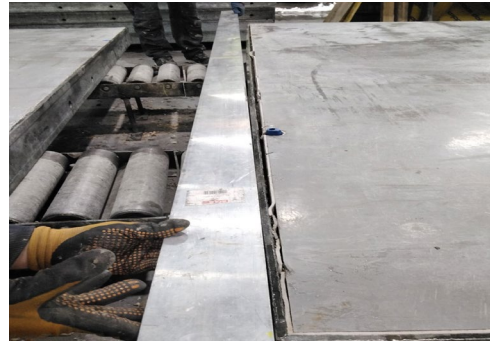
Lengteprofiel verbogen / paneelvervorming
