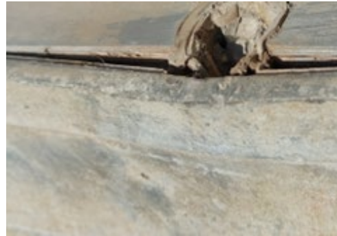
Anker gat beschadigd en lengteprofiel getorst
