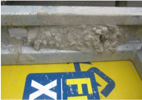
Binnenframe profiel gevuld met beton
