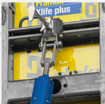
Bracon de stabilisation sur le coffrage (avec set de connexion pour tête d'étauçon)
