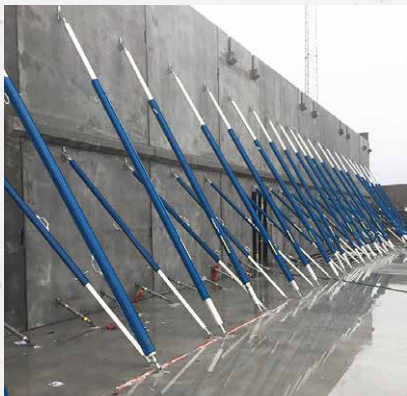
Éléments préfabriqués en béton
