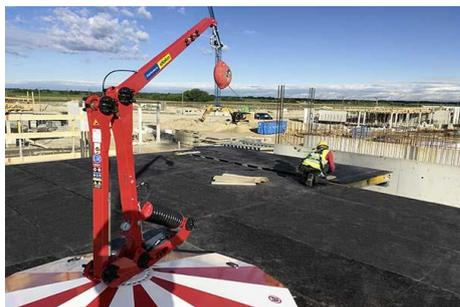
FreeFalcon est la synthèse idéale entre sécurité et liberté de mouvement. Avec ce dispositif mobile de sécurité anti-chute, les personnes sont sécurisées dès qu'elles encourent un risque de chute particulier.
