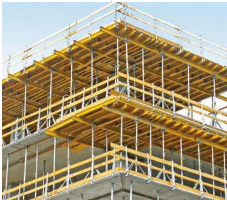
Solaio armato in sicurezza con sistema Dokaflex ▶
