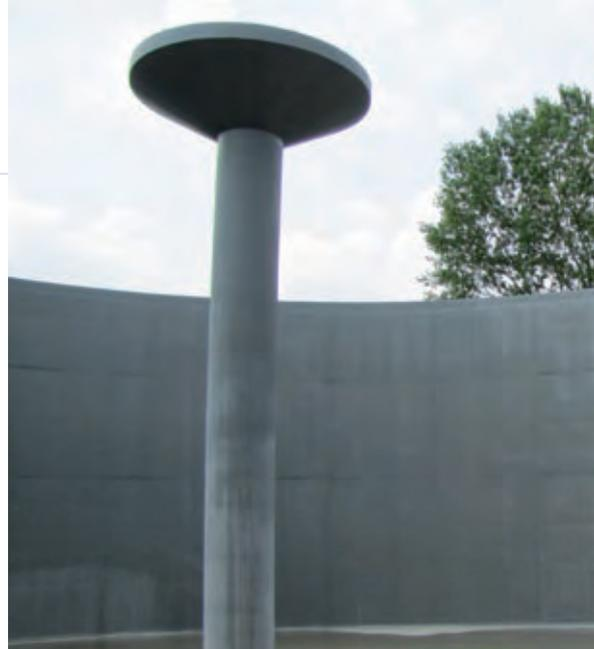
▲ La costruzione dei biodigestori avviene in fasi successive: il primo getto è alto 360 cm, quelli successivi 240 cm, fino al coronamento della struttura.
