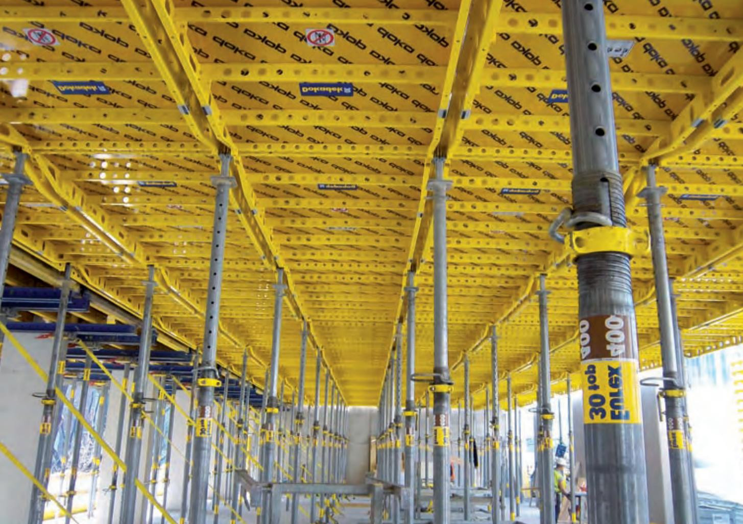
▲ Ogni solaio tipo è stato cassero con 800 m<sup>2</sup> di sistema Dokadek e 400 m<sup>2</sup> di tavoli Dokamatic sul perimetro
