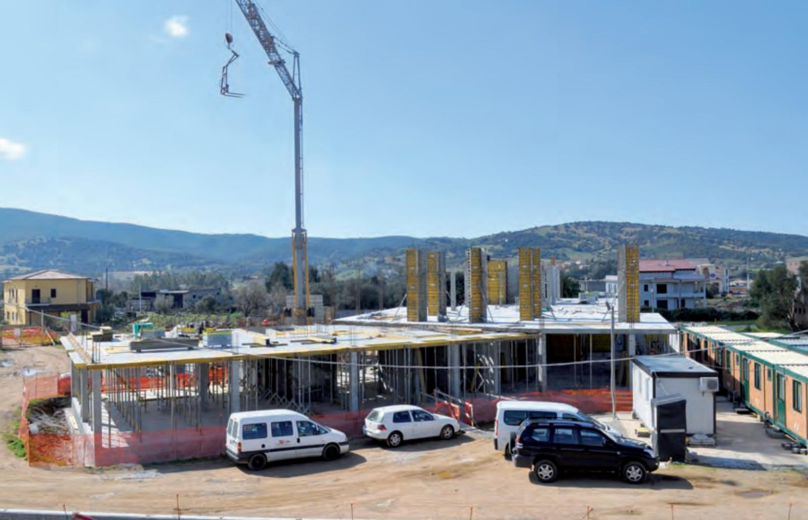
▲ La dotazione di 550 m<sup>2</sup> di Dokadek in opera sulla seconda metà del primo solaio.
