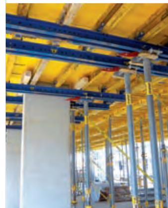
▲ Il sistema ad elementi Dokadek completa la gamma dei sistemi Doka per solai e si combina perfettamente sia con i sistemi flessibili, sia con i tavoli.
