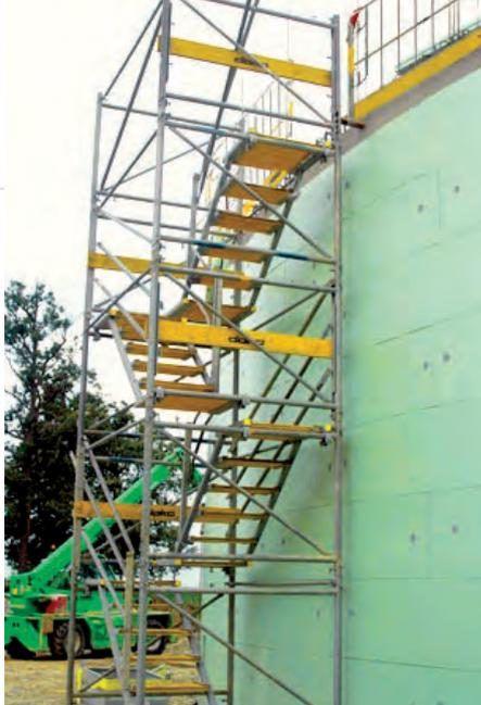
◀ La soluzione Doka per vasche e biodigestori è collaudata e completa di tutti gli accessori per la messa in sicurezza: passerelle, parapetti e torri scala per l'accesso.
