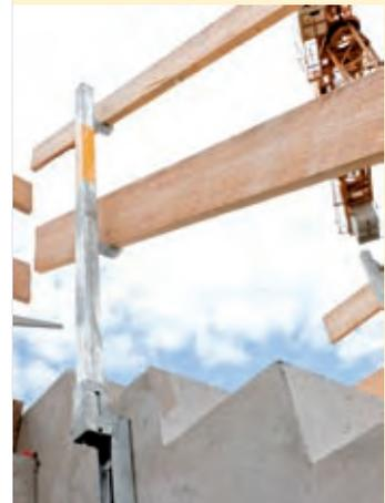
2. con scarpetta per parapetto XP e scarpetta per scala XP, entrambe con tassello meccanico
