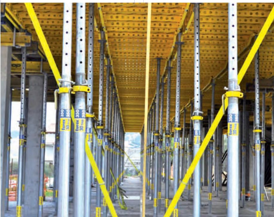
◀ La controventatura degli elementi Dokadek impiegati sul bordo solaio è necessaria per evitarne il ribaltamento.
