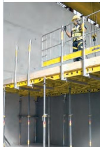
▲ Dokadek è compatibile con il sistema di protezione laterale XP, per la messa in sicurezza dei bordi solaio.
