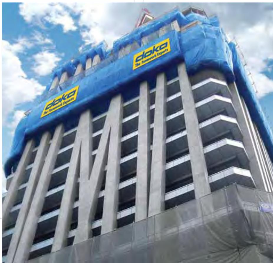
◀ La facciata della Tokio Marine Tower, alta 122 m, è caratterizzata da pilastri perpendicolari e inclinati che s'intersecano. Nessun problema per il sistema autorampante SKE50 plus, flessibile e completamente indipendente dalla gru.
