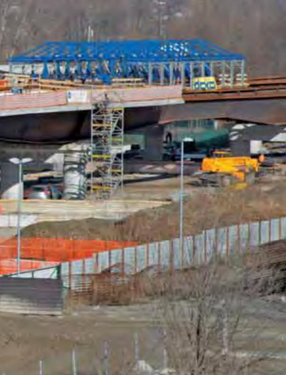
▲ Il Viadotto Valtellina è costituito da una struttura portante in acciaio, sulla quale i carri Doka realizzano le solette in cls
