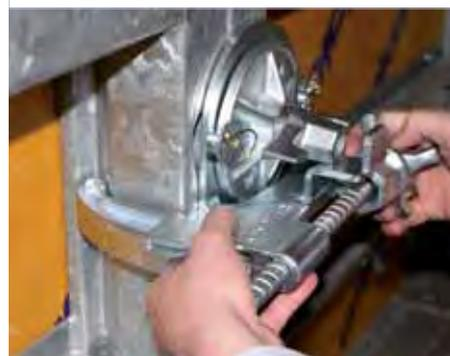
Il **sistema di ancoraggio Monotec** per casseforme a telaio Framax e per tutte le casseforme a travi Doka permette il serraggio lavorando da un solo lato. Può essere applicato su materiale già in uso in cantiere, e consente di ancorare rapidamente, con un ridotto impiego di materiale.
