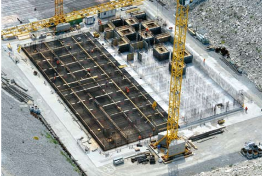
▲ Chioggia: vista dall'alto del primo cassone. I setti delle celle interne sono realizzati con Framax Xlife e angoli di disarmo
