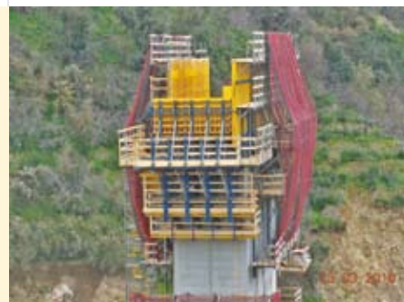
▲ Pulvino viadotto Favazzina, Consorzio SA-RC
