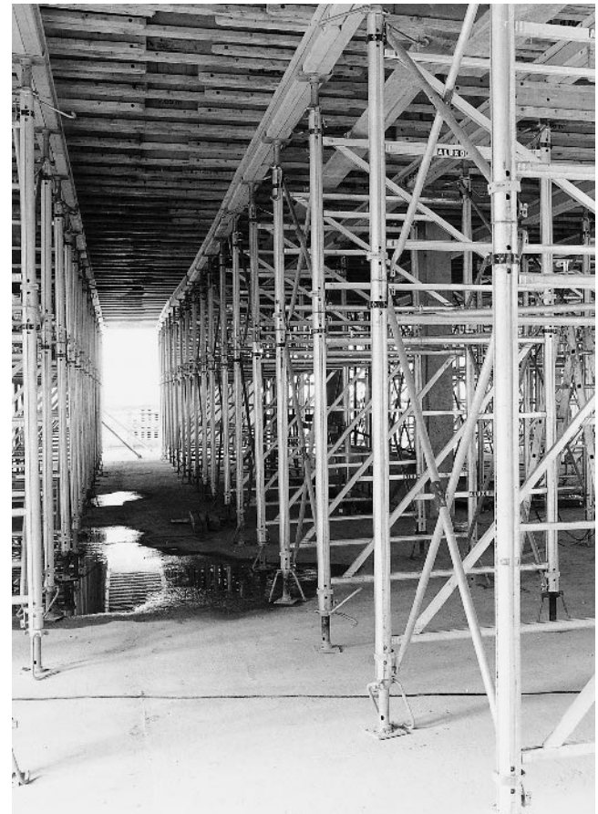
Rakennustyömaa: Bethanie-Krankenhaus, Chemnitz
