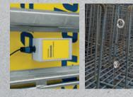
Der Kabelsensor ist mit bis zu drei Messpunkten ausgestattet und wird vor dem Betoniervorgang an der Bewehrung fixiert.
