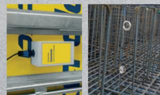
Il sensore con cavo è dotato di tre punti di misurazione e viene fissato all'armatura prima del getto.
