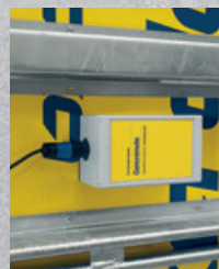
De kabelsensor is uitgerust met drie meetpunten en wordt, voordat het beton wordt gestort, aan de wapening bevestigd.
