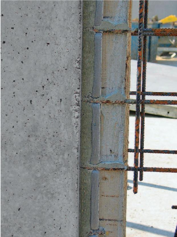
Торцевая опалубка с уплотнительным шнуром
