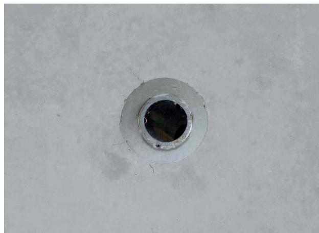
Герметичные анкерные крепления без "вытекания" раствора и выламываний
