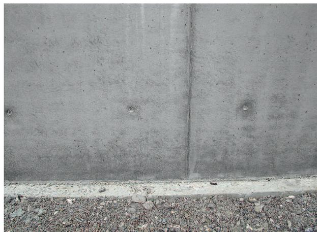
Вид бетона при использовании уплотнительного шнура
