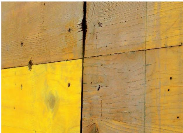
Пример: смещение в стыке элементов
