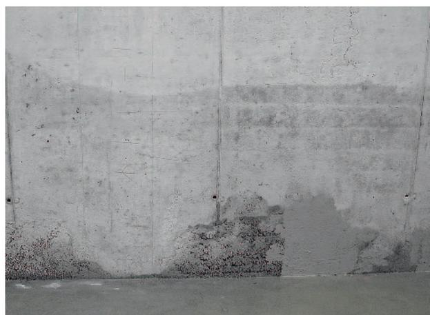
Вид бетона без уплотнительного шнура
