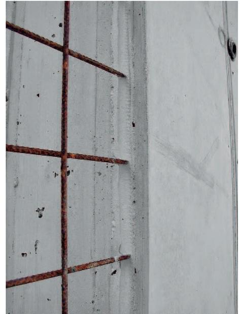
Пример: торцевая опалубка с уплотнением
