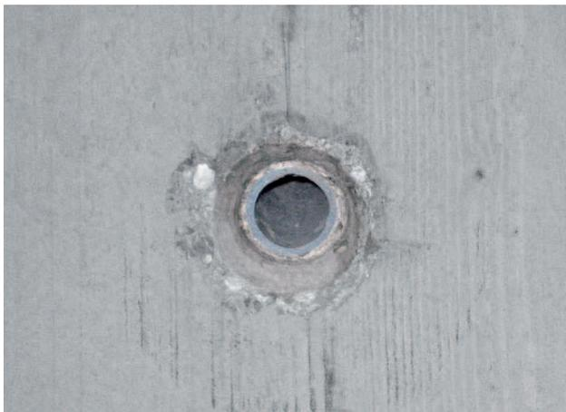
Выламывание бетона в месте анкерного крепления
