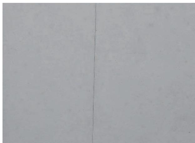
Картина бетона в зоне герметизации стыка между плитами Dokarplex
