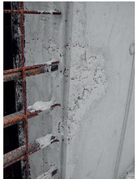
Пример: торцевая опалубка без уплотнения
