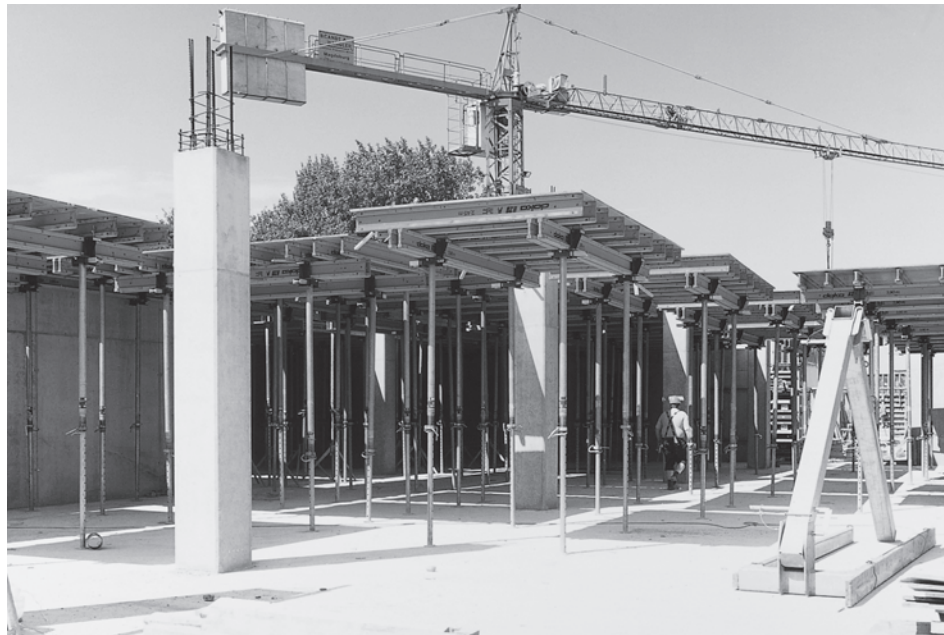
Строительная площадка: Университетская клиника в г. Магдебурге
