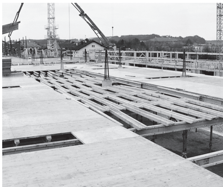
Строительная площадка: ARGE Porschehof, г. Зальцбург
