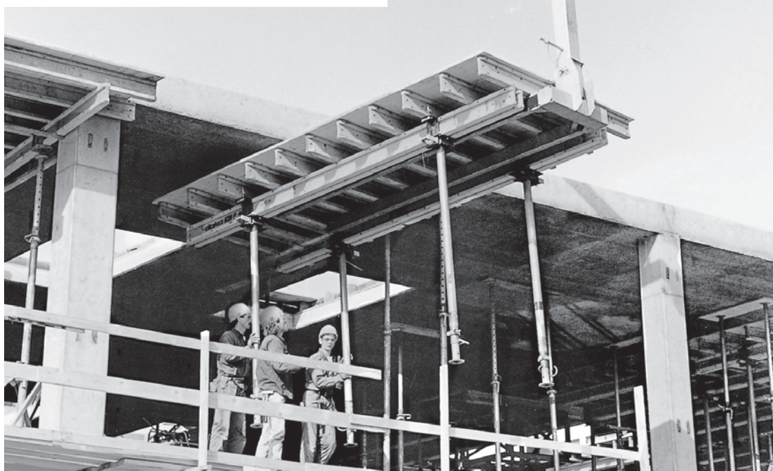
Строительная площадка: Складское помещение Клотцнер, г. Линц
