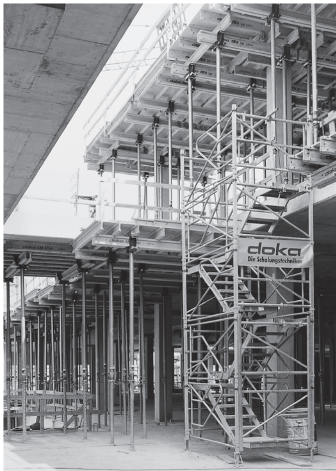
Строительная площадка: ARGE Westmünster Center, г. Бохолт
