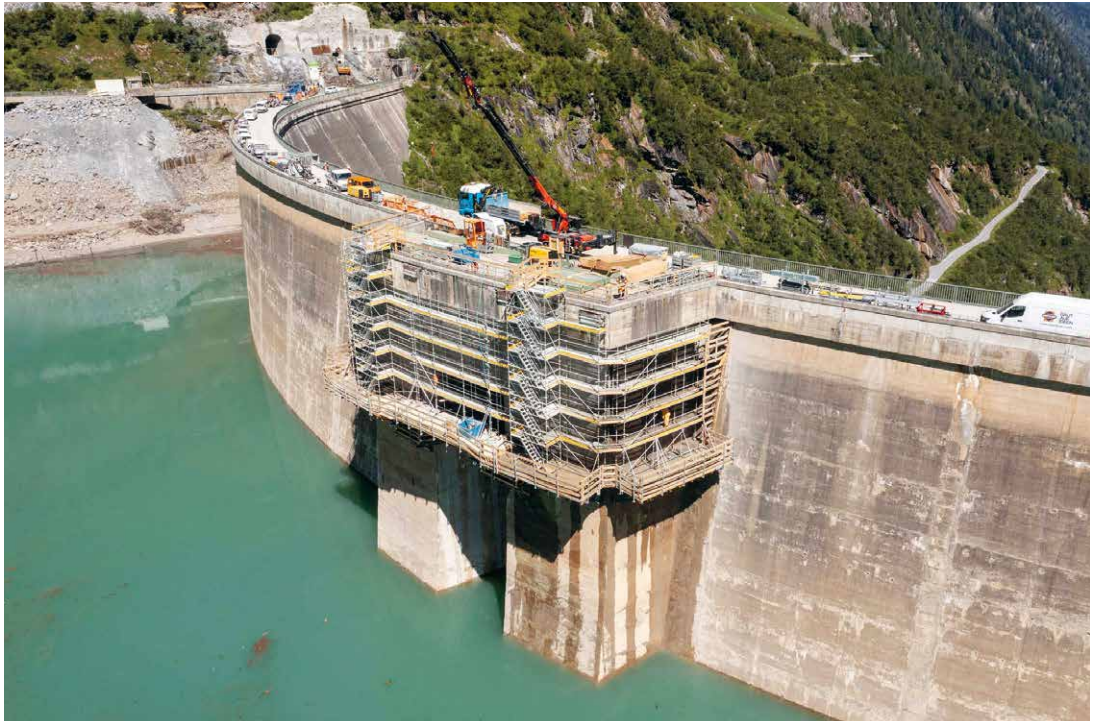
Perfektes Zusammenspiel: An der Staumauer Wasserfallboden greifen Schalung und Gerüst von Doka nahtlos ineinander.
