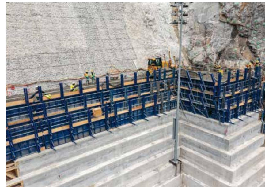
Neue Staumauerstufen werden mit einem flexiblen und leicht beweglichen System aus maßgeschneiderten und standardisierten Trägerschalungen geschalt.
