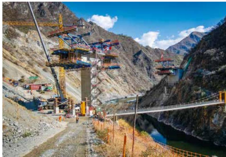
Sichere und effiziente Bauweise: Mit dem Doka-Freivorbauwagen wurde der Baufortschritt kontinuierlich vorangetrieben.
