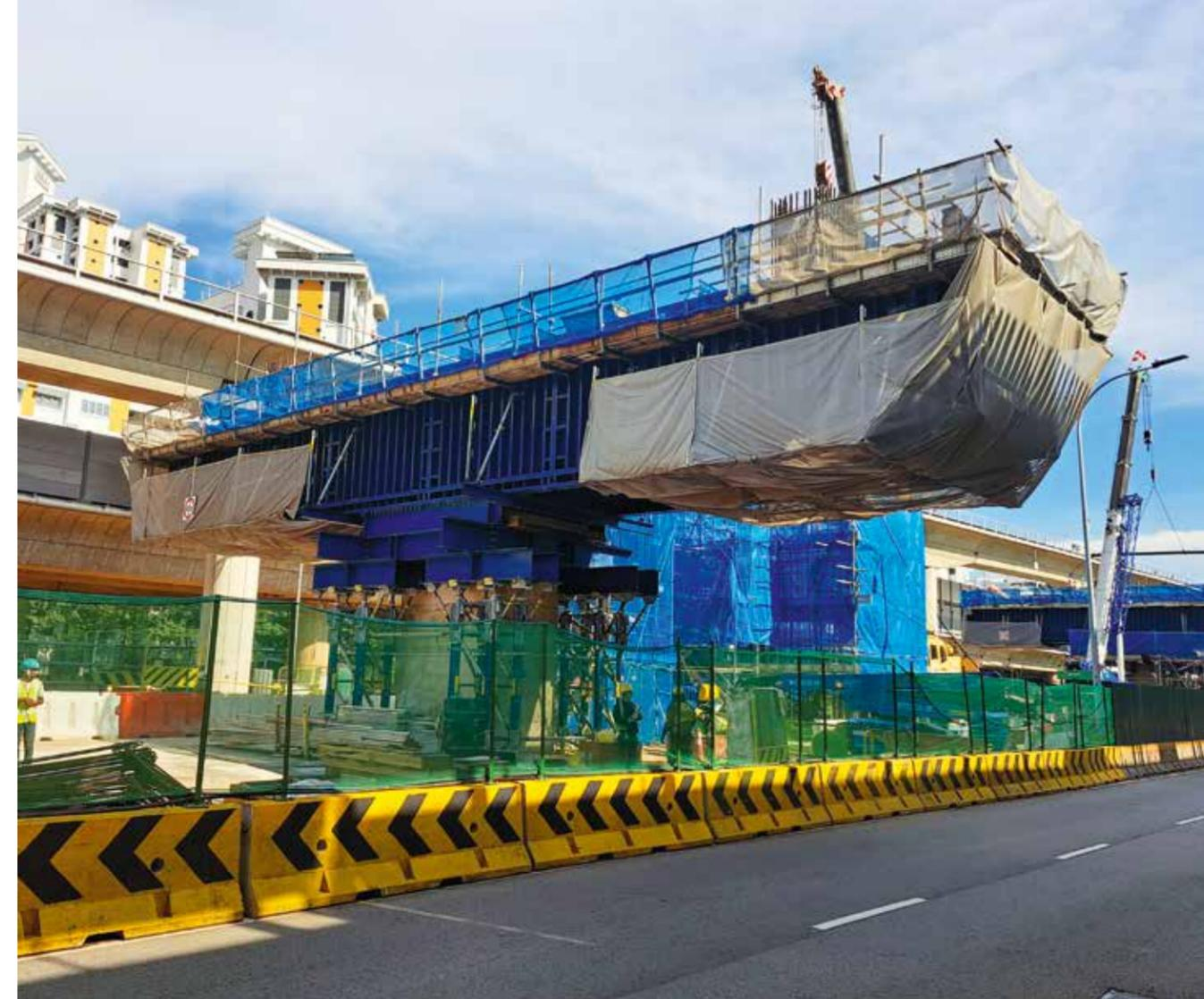
Die Doka-Stahlträgerschalung und der UniKit-Traggerüsturm sorgten nach nur einer Nacht Straßensperrung für die termin- und kostengerechte Fertigstellung eines wichtigen Bauabschnitts der Toh Guan Station.
