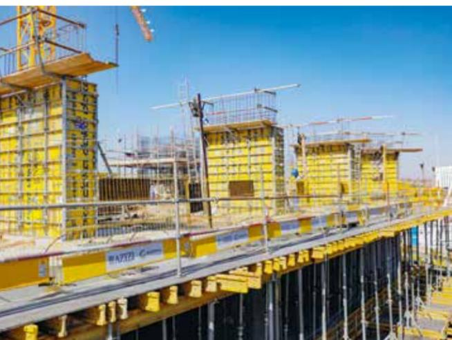
Die Rahmenschalung Frami Xlife, ideal für eine schnelle und wirtschaftliche Schalung, wurde für Stützen, den Gebäudekern und Schallschutzwände eingesetzt.
