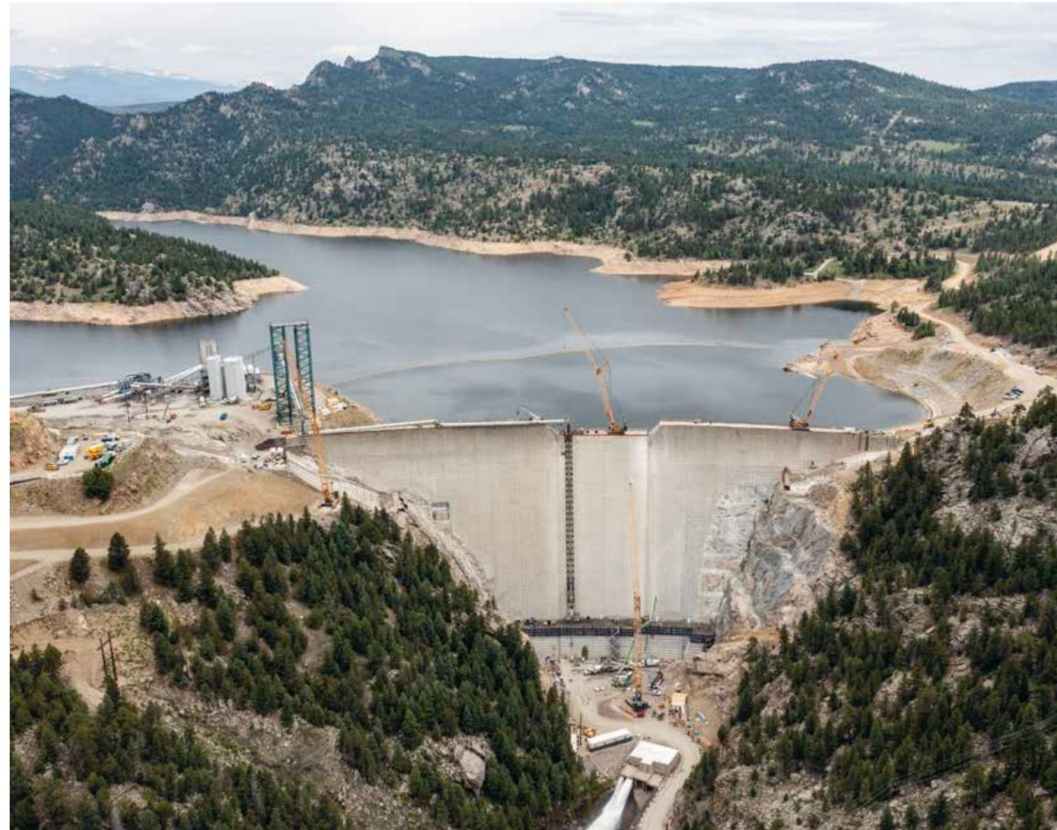
Der 70 Jahre alte Staudamm wird erweitert, um den steigenden Wasserbedarf der Region zu decken.
