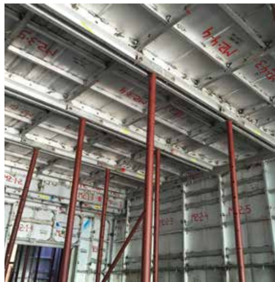
▲ Build smart: Doka Monolitics producido por MFE permite un encofrado altamente rentable logrado por un concepto de sistema lógico y adaptable.
