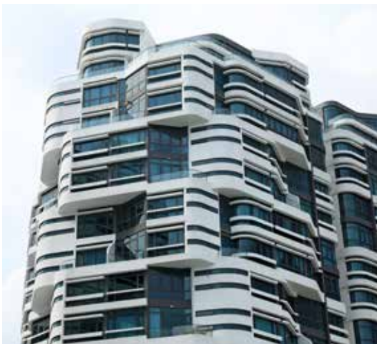
▲ Armonioso edificio residencial multigeneracional, donde se logró un objetivo de tiempo de ciclo de 5 días por piso debido a la solución de encofrado.
