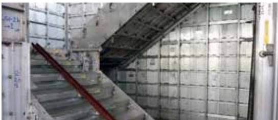
▲ Gracias al montaje de prueba, podemos garantizar en todo momento la configuración correcta del sistema, especialmente para áreas especiales como escaleras, paredes con formas especiales, etc.
