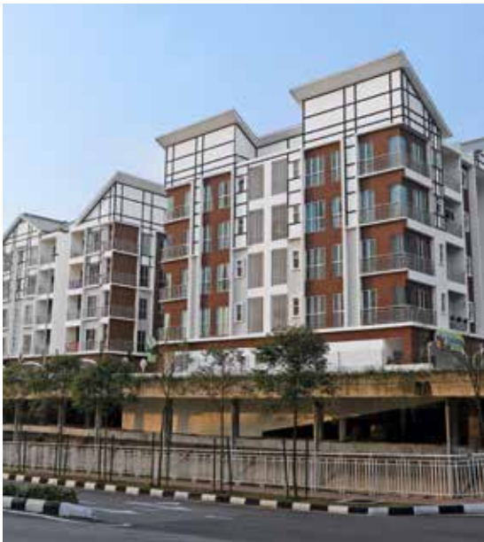
▲ Cameroon Highlands, Summer Square, consta de una planta baja y edificios de departamentos de tan solo 4 pisos con tiendas minoristas a nivel del suelo. Las unidades de las tiendas se colaron en primer lugar y las losas de los departamentos se finalizaron a un ritmo de un piso cada 5 días.
