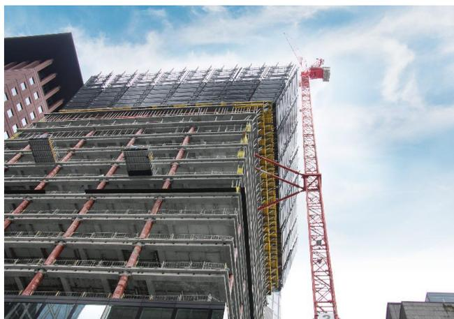
In marzo, lo schermo di protezione ha raggiunto l'inclinazione più estrema. Da quel livello in poi, i piani saranno sfalsati all'indietro e, una volta raggiunto di nuovo il livello della base, torneranno ad elevarsi verticalmente.
