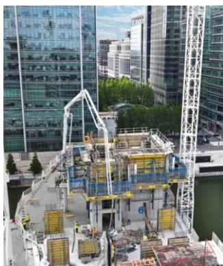
Il nuovo edificio del Canary Wharf, Wood Wharf, a Londra, è stato progettato per realizzare oltre 3.300 abitazioni. L'edificio A2 ha 14 piani, mentre l'A3 ha ulteriori 44 solai di calcestruzzo. Complessivamente la costruzione degli edifici A2 ed A3 richiede l'impiego di 5.600 tonnellate di armatura, 31.000 m<sup>2</sup> di calcestruzzo e 65.200 m<sup>2</sup> di cassaforma per solai.
