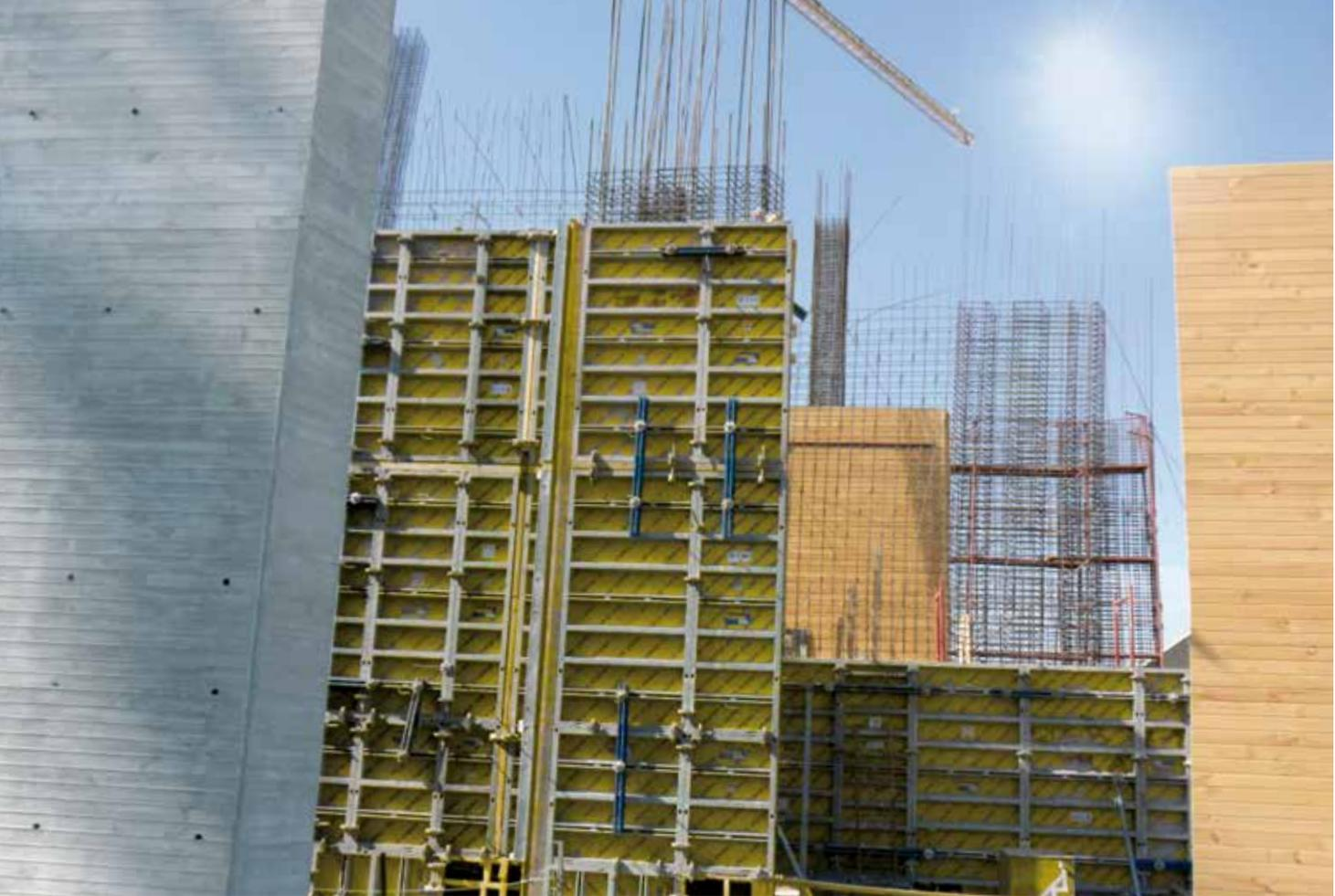
▲ Utilización de placas con aplicación de lengüetas y ranuras garantiza el efecto deseado en el concreto visto.
