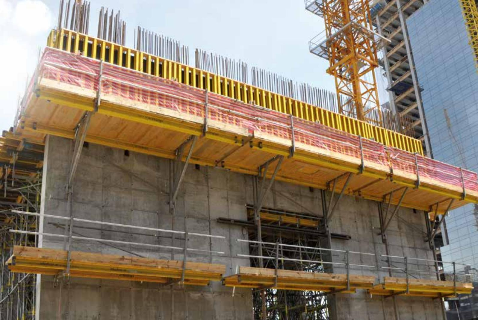
▲ Encofrado trepante MF240 utilizado para apoyar el encofrado y para el trabajo en las paredes exteriores.
