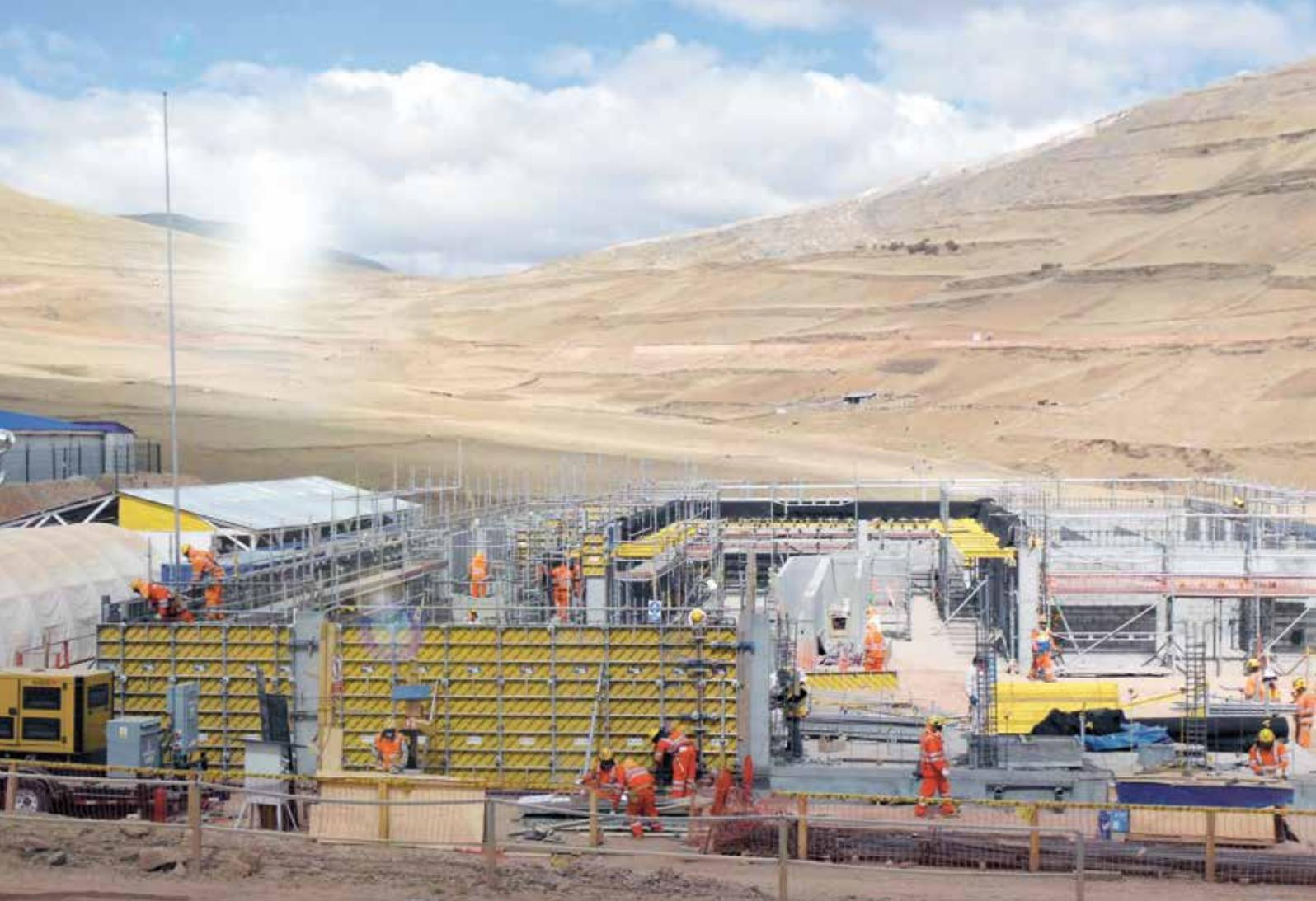
▲ El encofrado muestra un alto margen de rendimiento para elementos verticales.
