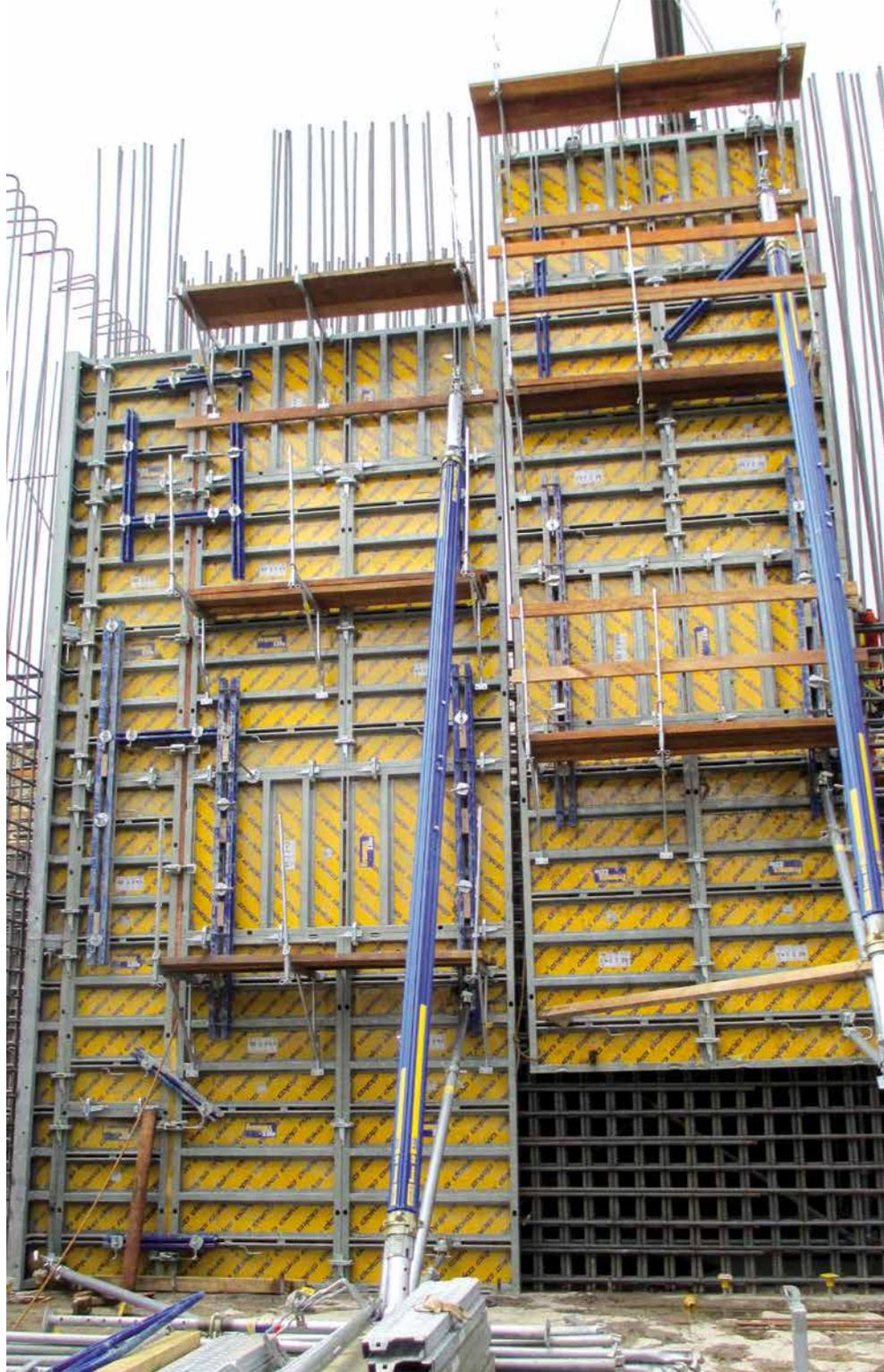
▲ Paredes com até 7 m de altura são concretadas de uma única vez com Framax Xlife.
