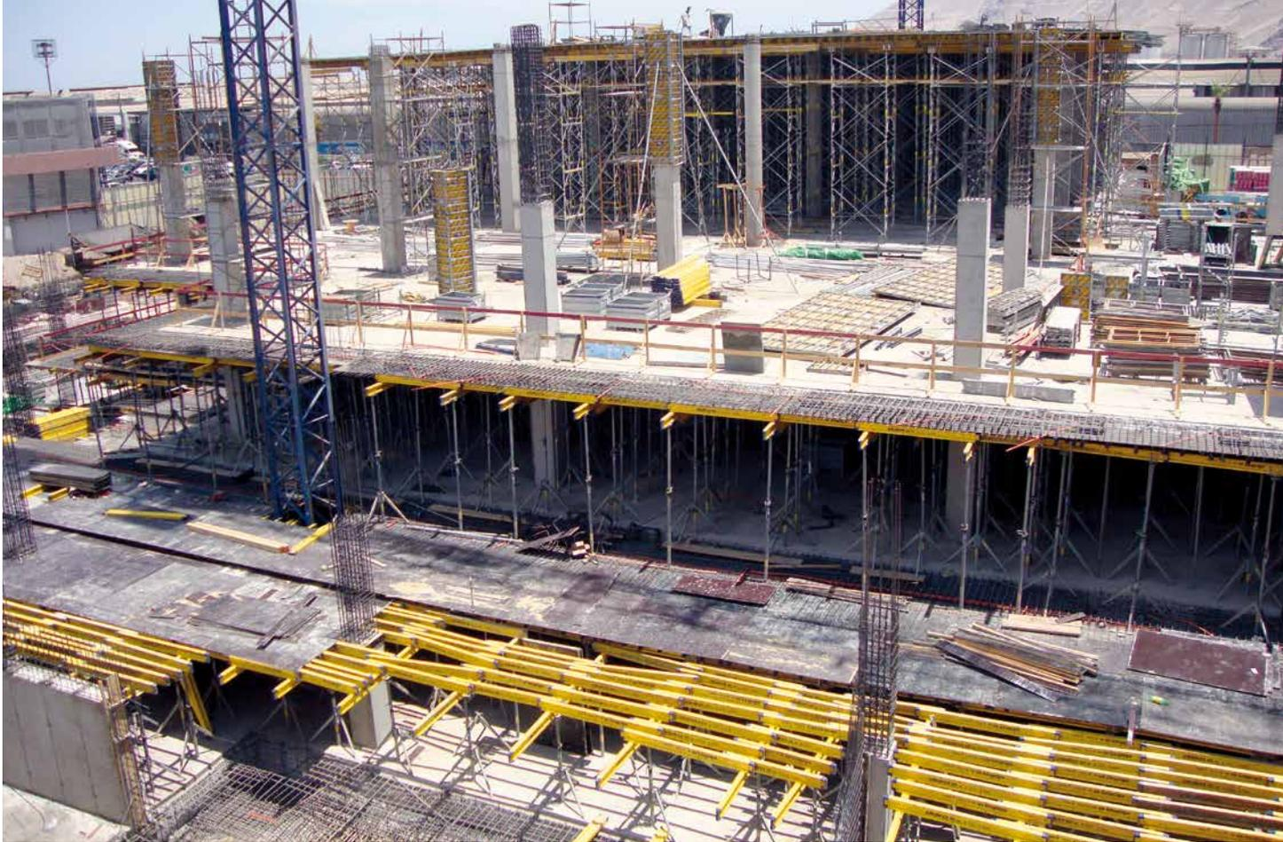
▲ A combinação da torre de carga Staxo 40 com o sistema Dokaflex é ideal para execução das lajes em grandes alturas.
