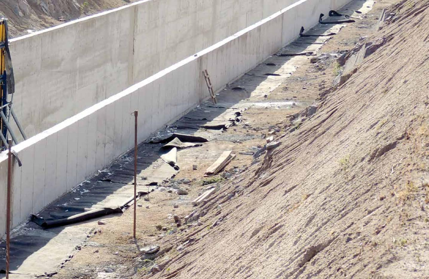
Em toda extensão do canal temos sifão em aço, túneis, canais retangulares, comportas, travessias e bueiros. A otimização da produção deu-se através da utilização da escavadeira hidráulica, como meio de deslocamento das fôrmas, já que o local confinado e de difícil acesso, chega a uma profundidade de até 25 metros.
