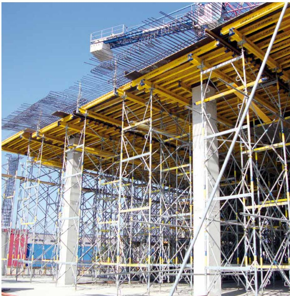
▲ As torres de cargas Staxo 40 podem ser pré montadas na horizontal e posteriormente posicionadas com grua.
