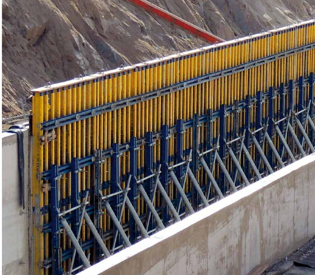
▲ Os Contrafortes permitem a absorção segura das forças de concretagem por meio de ancoragens inclinadas.
