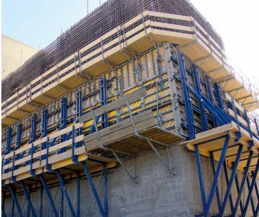
▲ Encofrado de presas D22, con alta capacidad de carga y seguridad en el trabajo.
