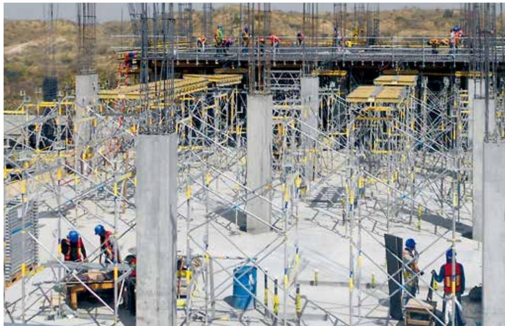
▲ Staxo 40, una mayor estabilidad a la estructura de las losas y facilidad en el manejo.
