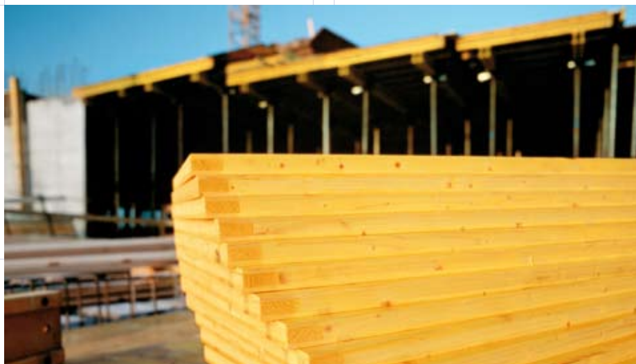
► Panele sklejki 3SO na budowie
