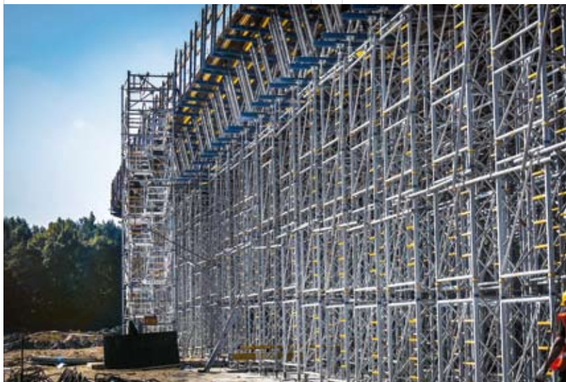
▼ Zabezpieczenia BHP - Schodnia 250 i pełne obarierowanie deskowania
