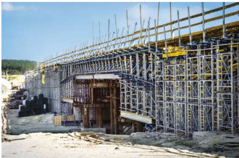
▲ Bramka przejazdowa na ryglach HEB i rusztowanie Staxo 100
