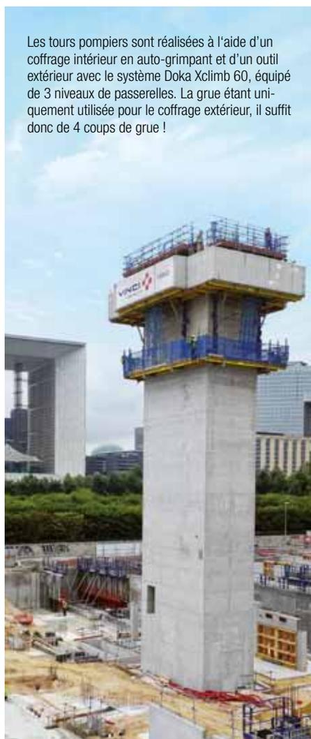
Les tours pompiers sont réalisées à l'aide d'un coffrage intérieur en auto-grimpant et d'un outil extérieur avec le système Doka Xclimb 60, équipé de 3 niveaux de passerelles. La grue étant uniquement utilisée pour le coffrage extérieur, il suffit donc de 4 coups de grue !
