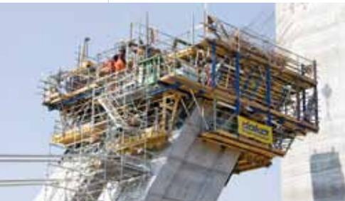
▲ 16 betonagens de 2,10 m com cofragem autotrepante SKE 50.
