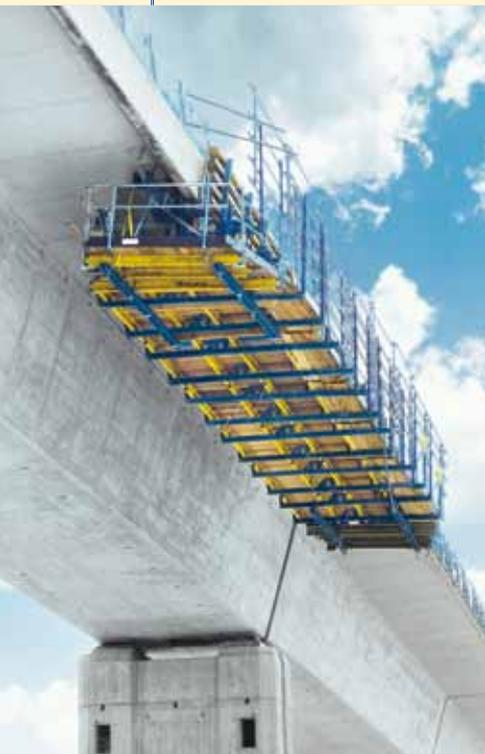
▲ O carro cofragem TU permite betonar bordaduras de tabuleiro em consola, sem ocupar espaço na área superior.
