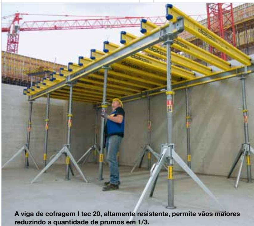
A viga de cofragem I tec 20, altamente resistente, permite vãos maiores reduzindo a quantidade de prumos em 1/3.
