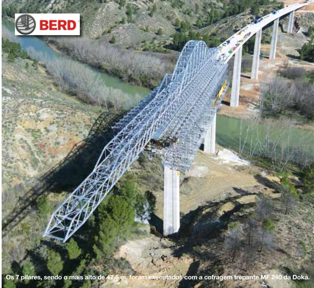
Os 7 pilares, sendo o mais alto de 47,5 m, foram executados com a cofragem trepante MF 240 da Doka.
