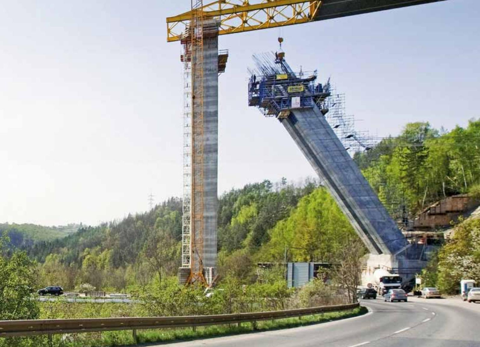
rar apenas as cargas do processo de betonagem, como também o peso das cargas sobre o desvio da inclinação. Nesta ponte encontramos, a cada 2 betonagens 2,10 m, uma peça de betão pré-fabricada. A solução oferecida para a cofragem interior permitiu libertar a cofragem autotrepante de uma parte do peso do betão, o que facilitou consideravelmente a utilização do sistema autotrepante para a cofragem exterior.
