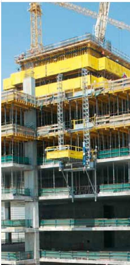
◀ Com a nova versão autotrepante do sistema de elevação de mesas TLS se podem agora cofrar lajes sem a ajuda de grua, aumentando em muito a segurança em obra durante as operações de elevação.
