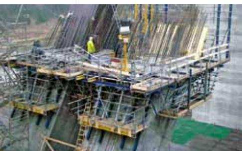
▲ Pilares com uma inclinação de 33° sobre a vertical.
