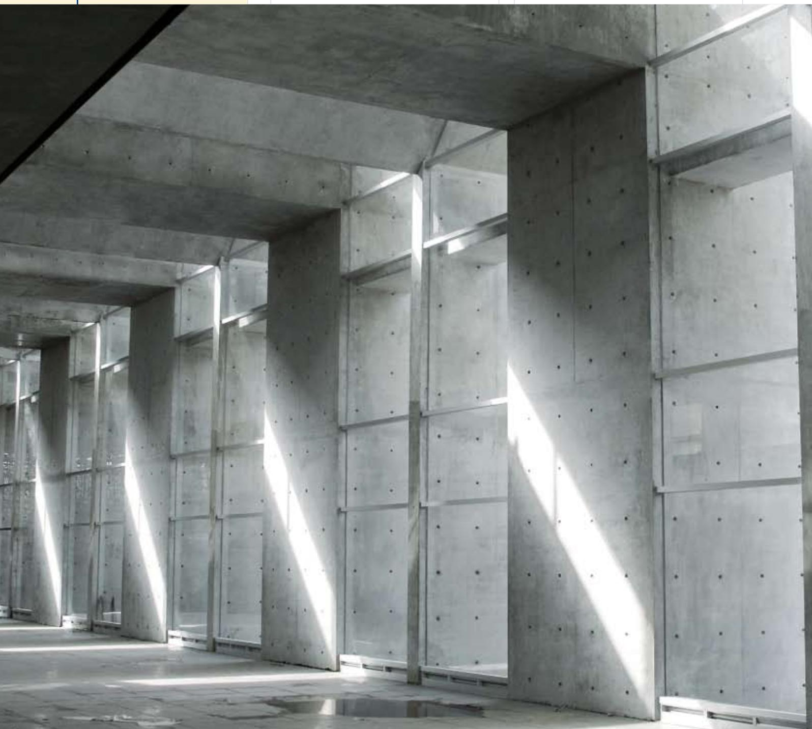
▲ Para assegurar junção exacta dos elementos, a Doka México planificou e pré-fabricou oito conjuntos de cofragem de vigas Top 50, com uma superfície total de 900 m<sup>2</sup>.
