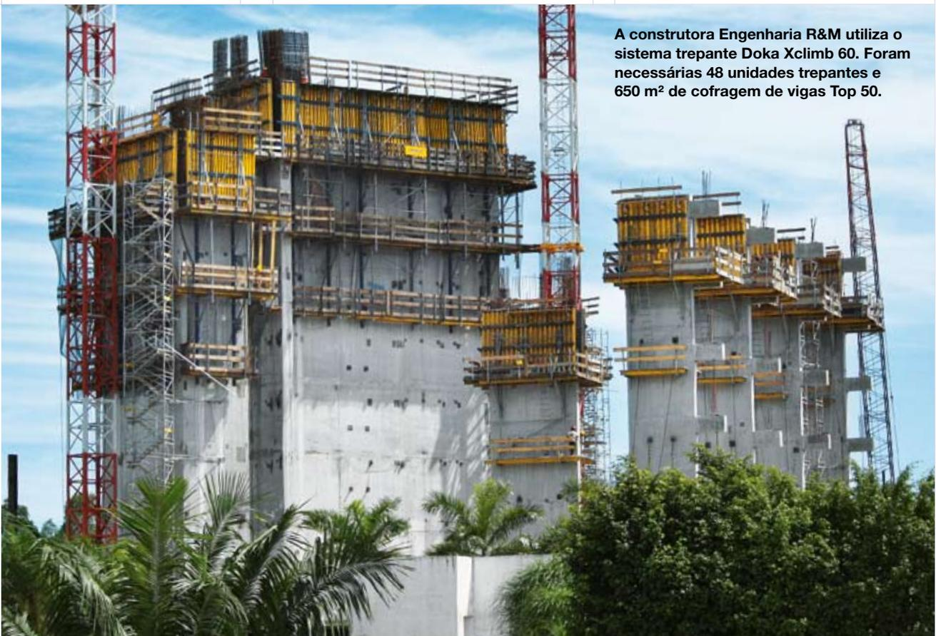
A construtora Engenharia R&M utiliza o sistema trepante Doka Xclimb 60. Foram necessárias 48 unidades trepantes e 650 m<sup>2</sup> de cofragem de vigas Top 50.
