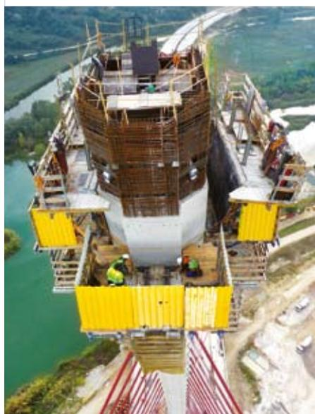
◀ A cofragem autotrepante e o sistema de proteção de perímetro garantem máxima segurança para o pessoal em obra.
