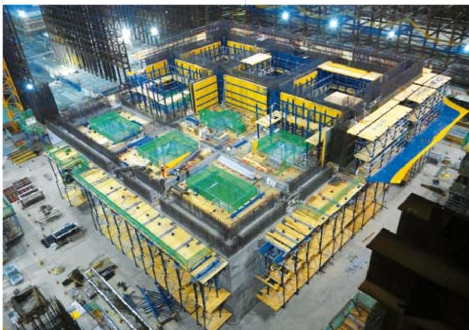
◀ O sistema trepante SKE100 para o núcleo chegou à obra. 117 consolas trepantes elevaram a cofragem e três bombas de betão.
