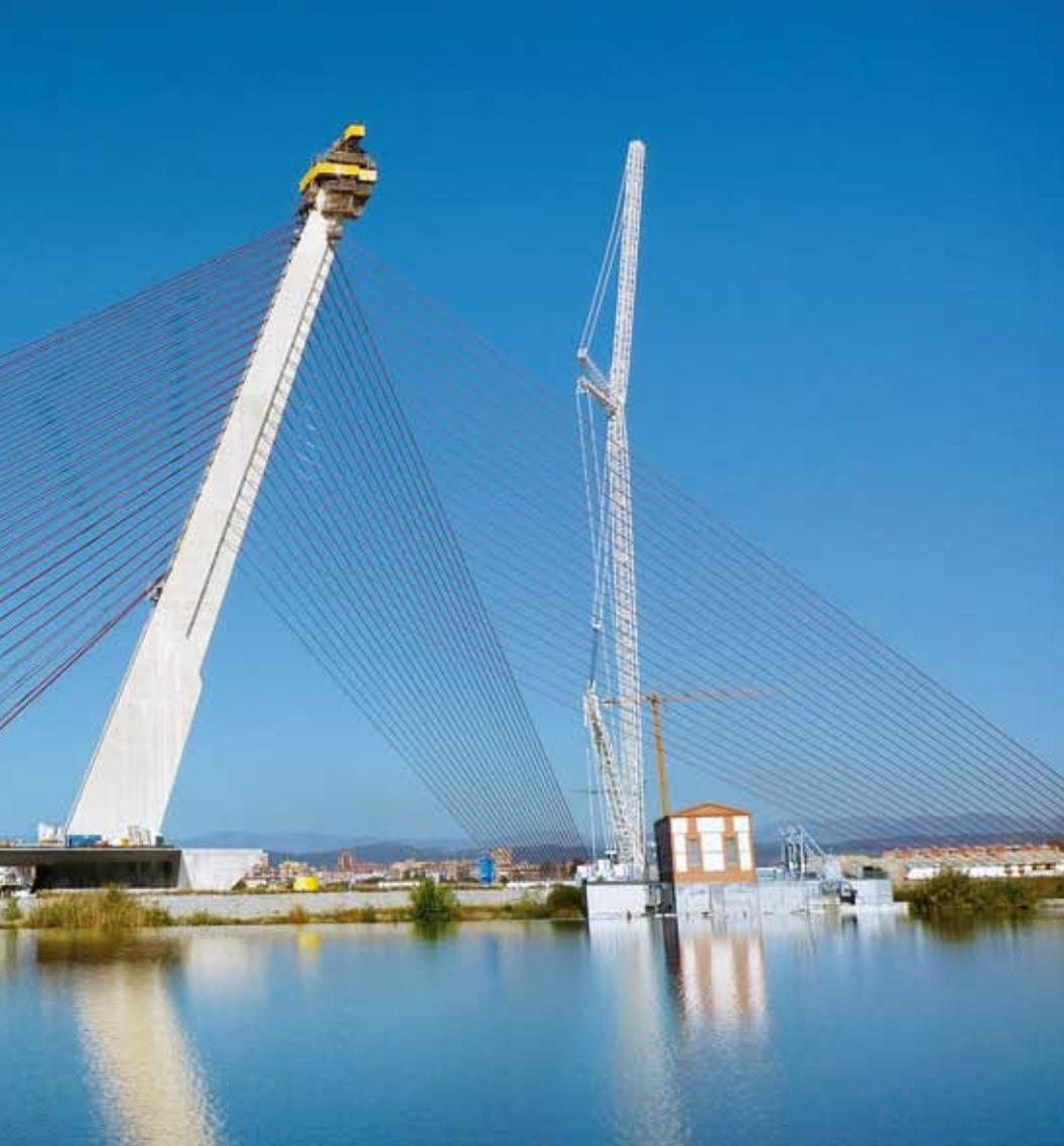
◀ O pilar foi erguido e, um a um, foram instalados os tirantes que suportam o peso da ponte.
