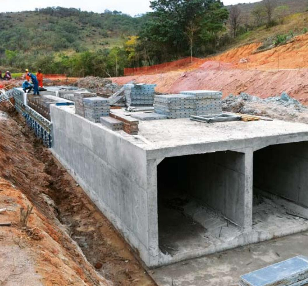
◀ **Doka Brasil** forneceu a cofragem de painéis Frami Xlife para construir passagem hidráulica.
