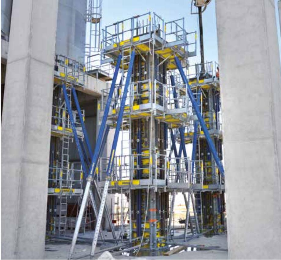
◀ Les poteaux en béton coulés en place se coffrent facilement et rapidement avec les panneaux et les angles extérieurs de la gamme Framax Xlife.
