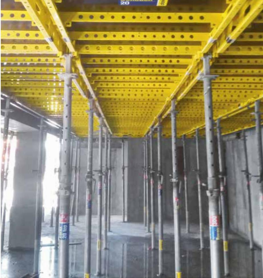
▲ Le système Dokadek 20 permet de coffrer les planchers en travaillant depuis le sol, en sécurité et en ergonomie.
