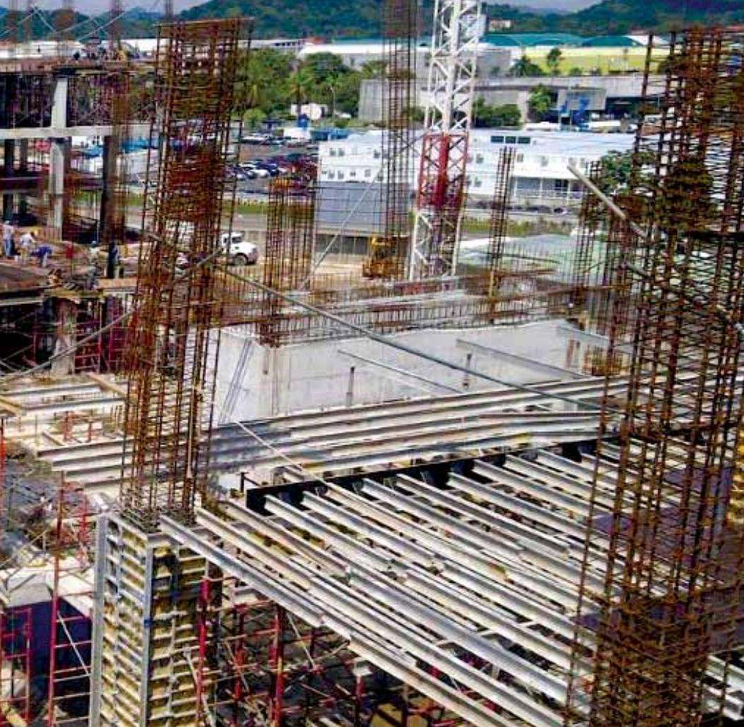
◀ Edifício em forma de H, com sistemas para paredes e lajes da Doka
