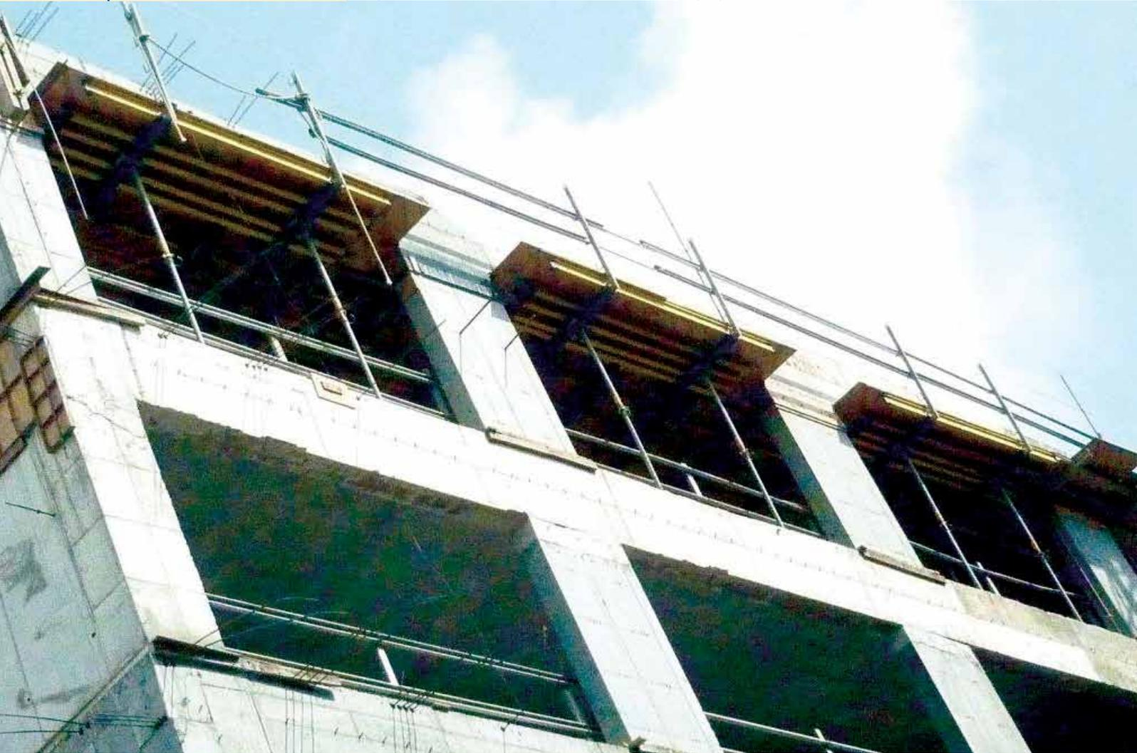
▲ Plataforma de segurança integrada ao sistema para um trabalho seguro no perímetro da laje
