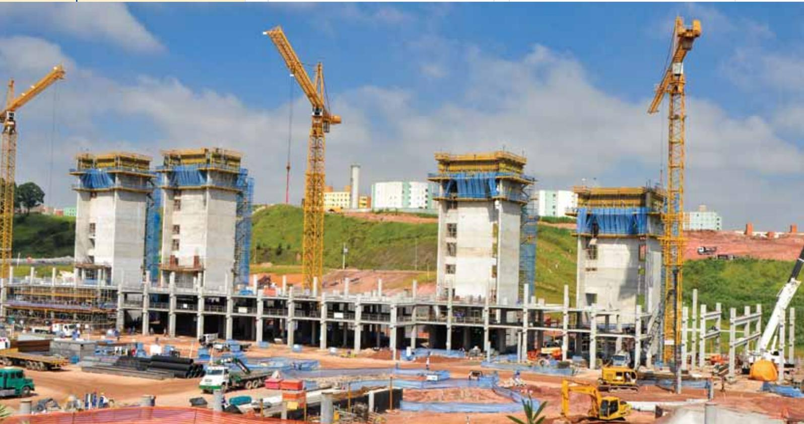
▲ Sistema de fôrma trepante para a execução do concreto aparente nos núcleos do prédio oeste
