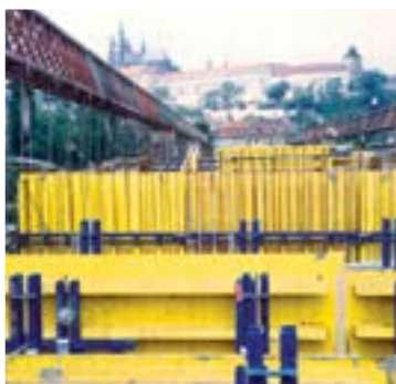
První realizací s bedněním Doka v ČR byla rekonstrukce Mánesova mostu v Praze
